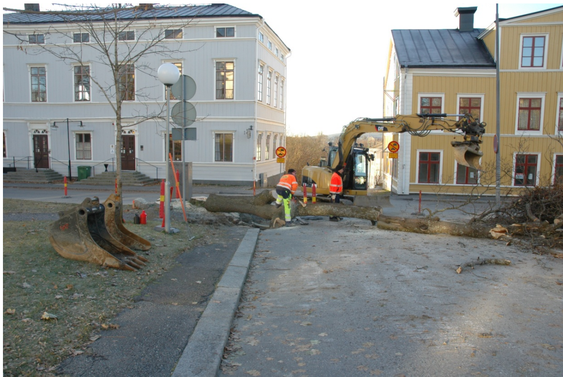
Schakt 1. Trädfällning utefter Franzengatan
