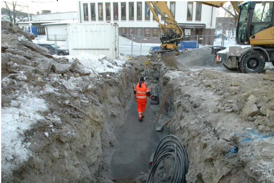
Schakt 4. Foto från norr.
