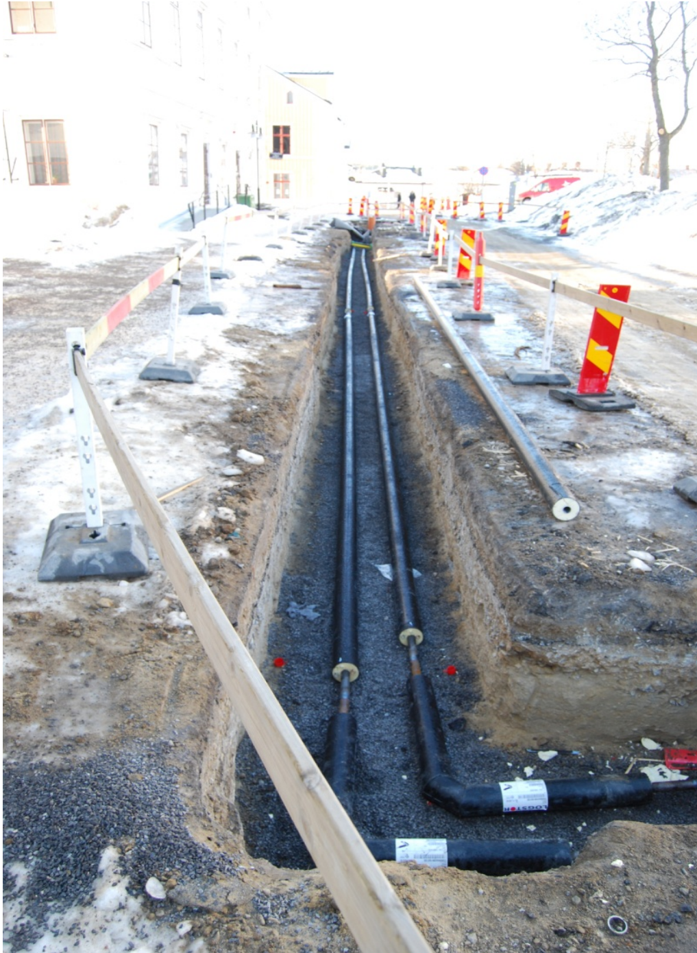
Schakt 3. Foto från öst.
