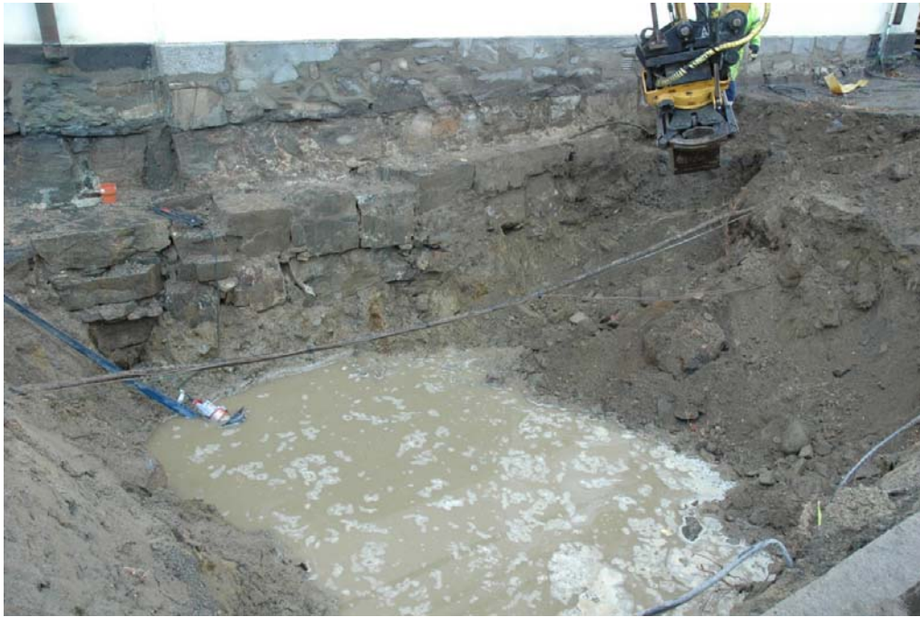
Schakt 2. Utefter kyrkomuren, första grävtagen. Foto från söder.
