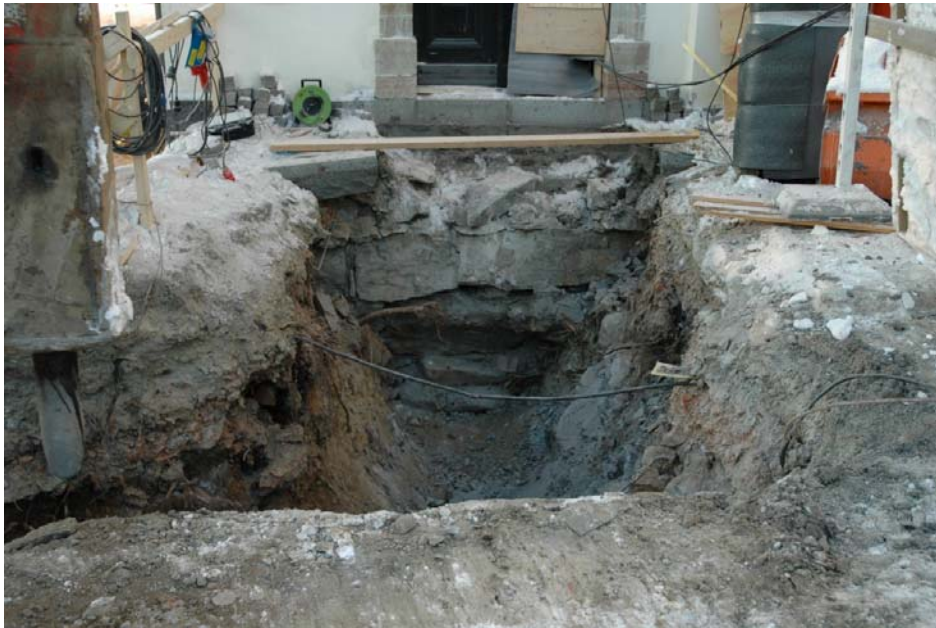
Schakt 4. Foto från öst.
