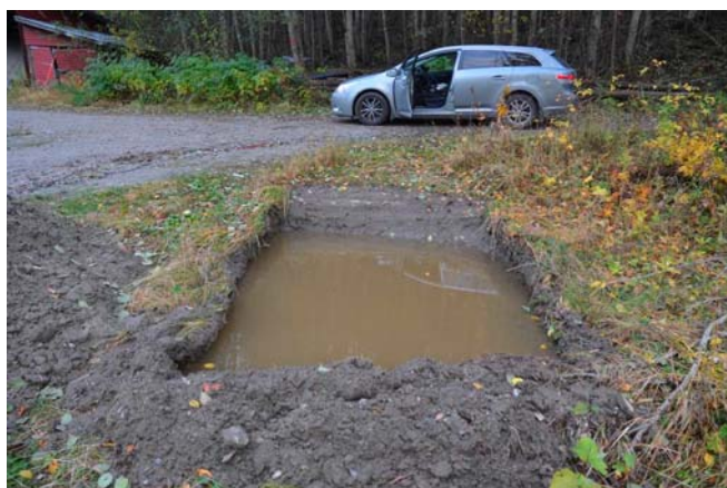
Figur 6. Schakt 1, efter en regnig helg, mot NÖ. Foto nr. DSC0164. Foto: Óskar Leifur Arnarsson.
