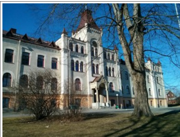
Kiörningskolan, Norrlands enda ”dövstumskola” på sin tid.
