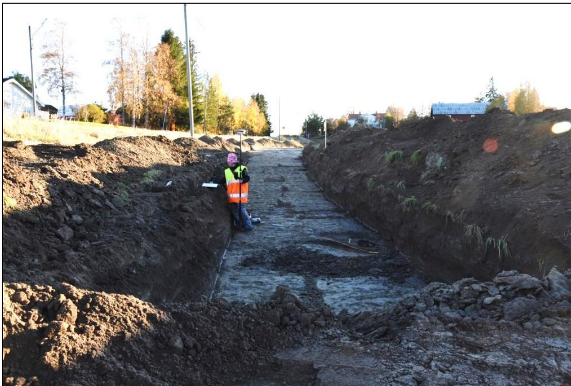
Fig. 13. Norra delen av schaktet, foto från norr
