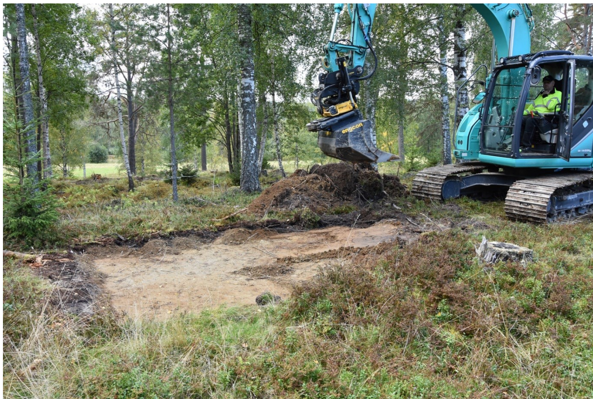
Figur 6. Schakt 6 efter avtorvning. Foto från norr.
