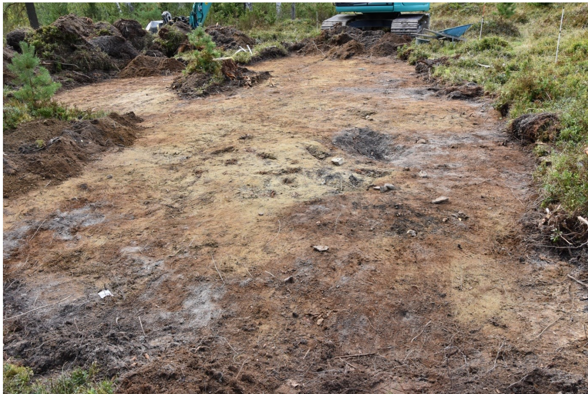
Figur 5. Schakt 5 efter avtorvning. Foto från öster.
