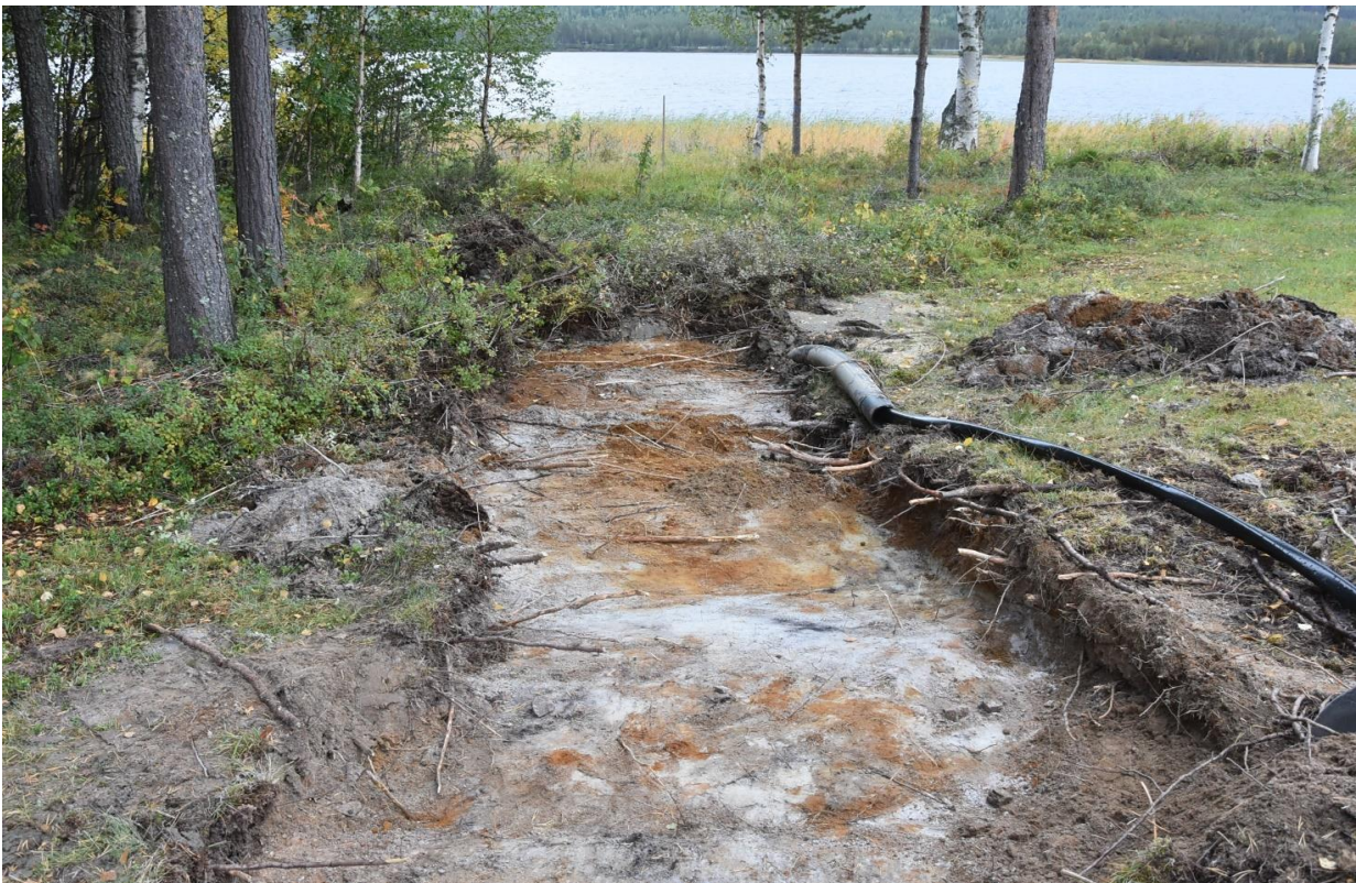
Figur 4: Södra delen av på schaktet i område 1. Foto från nordöst.
