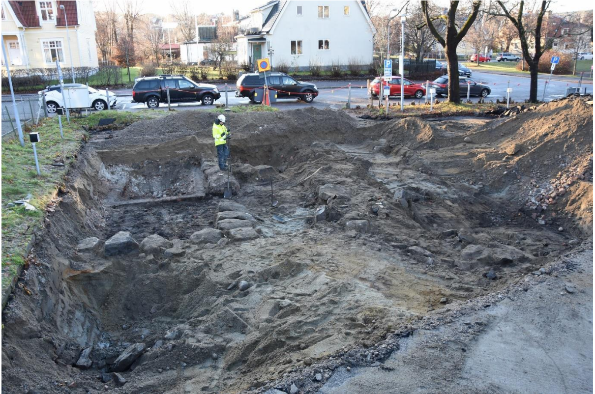
Figur 9. Översiktsbild av det sydöstra schaktet. Foto M. Bäck.
