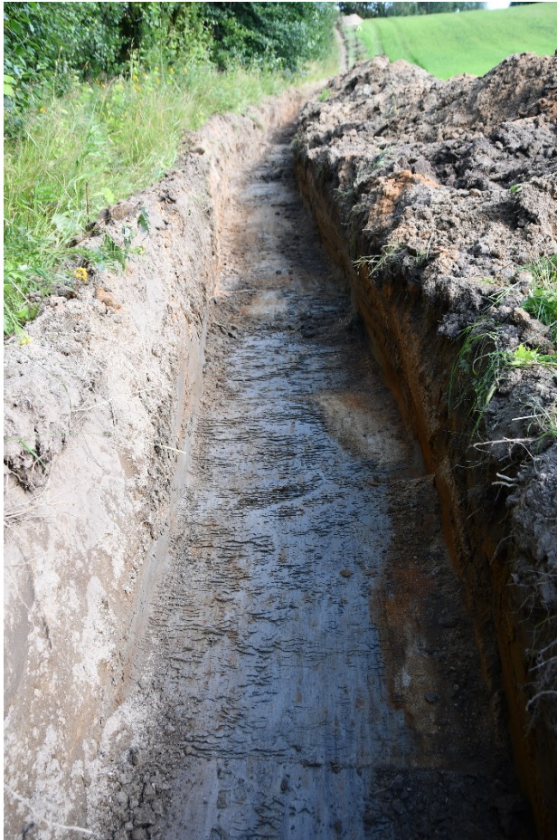
Figur 9. Schakt i västra delen av undersökningsområdet på åkern. Fläckvis fanns lera i botten. Foto från sydväst.
