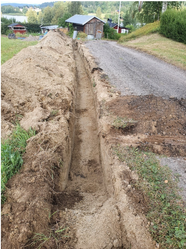
Figur 25. Schakt längs grusvägen längst i den östligaste delen av undersökningsområdet. Foto från öster.
