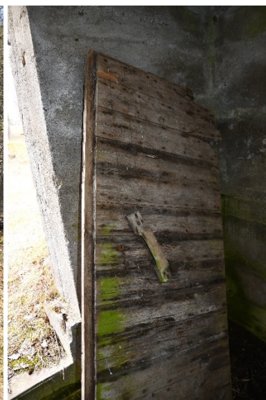
Fig. 11 dörr till jordkällare.
