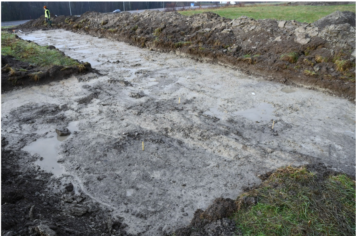
Figur 50. Översikt över schakt 48. Foto från syd.
