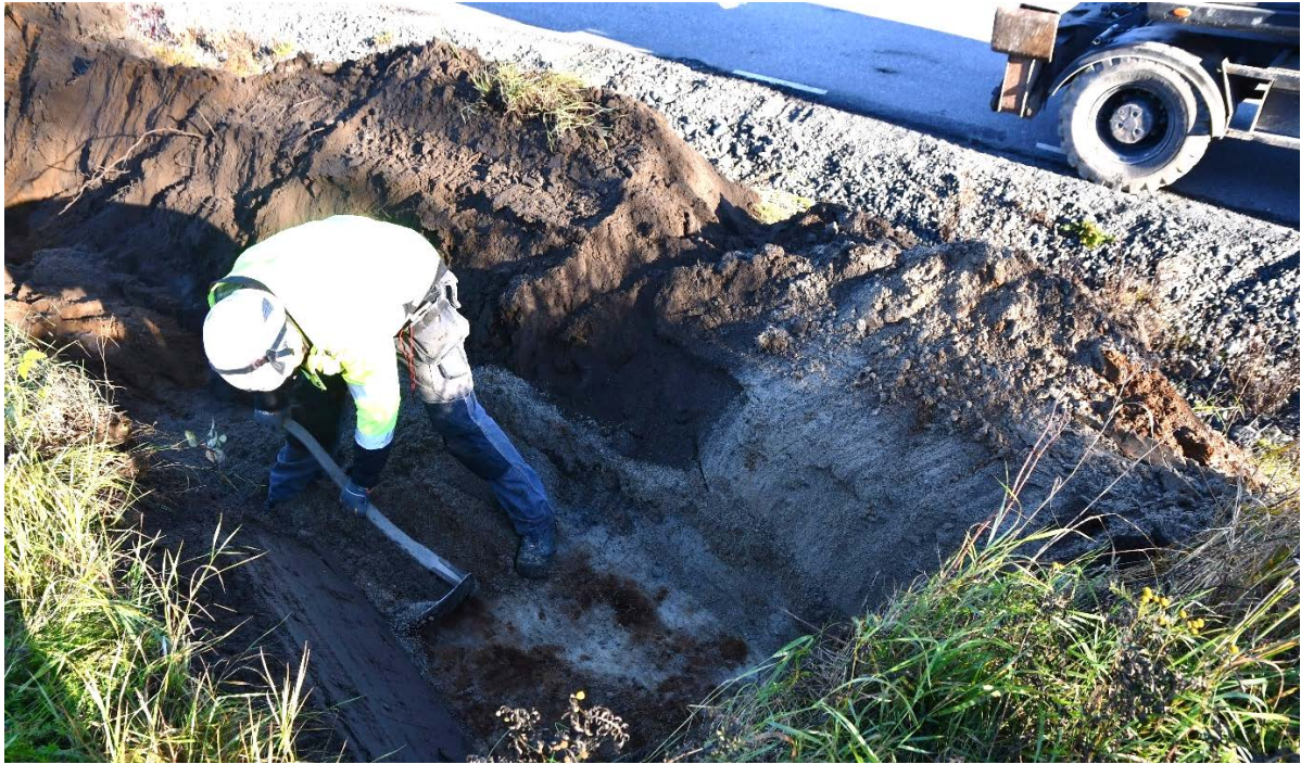
Fig. 4. Arbetsbild schakt 1. Foto från S.
