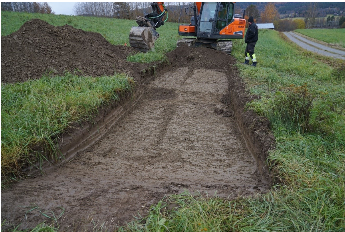
Fig. 18. Schaktning påbörjad vid L1935:9814. Foto från N.
