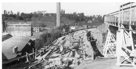
Et flyfoto fra 1934 viser den nye betongviadukten til erstatning for hovedvegen mellom Tarrisboligene og jernbanen. Byggingen sysselsatte mange i de vanskelige 1930-årene.
