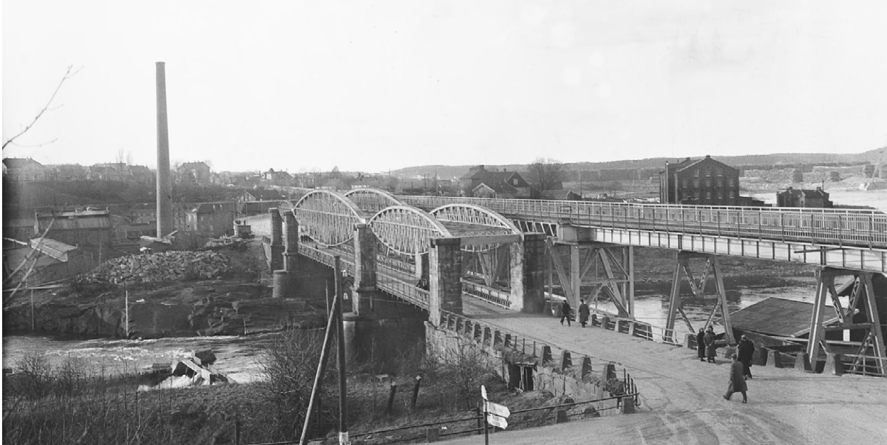
I 1931 bygde Jernbanen sin egen bru og ga Sarpsbrua tilbake til Vegvesenet: Tilfartene ble fjernet, men de karakteristiske pauliske dragerne ble værende slik i fire år til. (Foto fra Østfold fylkes billedarkiv)
