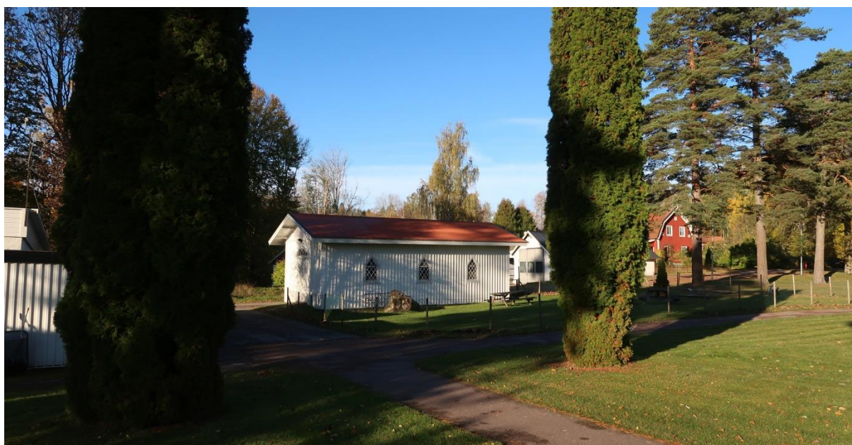
Den tidigare bårboden används idag som förrådsbod. Fasadens beläggning är äldre med locklistpanel samt spetsiga spröjsade fönsterbågar. En asfalterad gång flankerad av två höga tujor längs syd-östra sidan leder in på kyrkogården.
