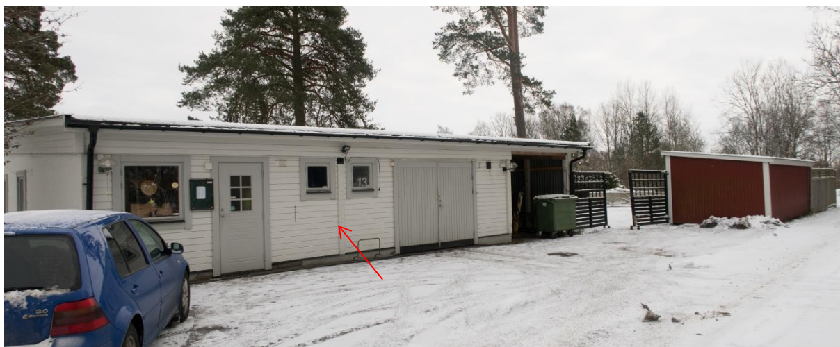
Vid sidan av den äldre förrådsboden står byggnaden med personalutrymmen/kontor etc. samt en öppen carport/förråd. Byggnadsdelen till vänster om pilen är ursprunglig (ombyggd), garage-och förrådsdelen tillkom år 2007.
