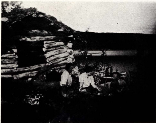
Løe av laftet bjørk, den mest vanlige byggemåten for markløer i Dalsbygdtraktene.
