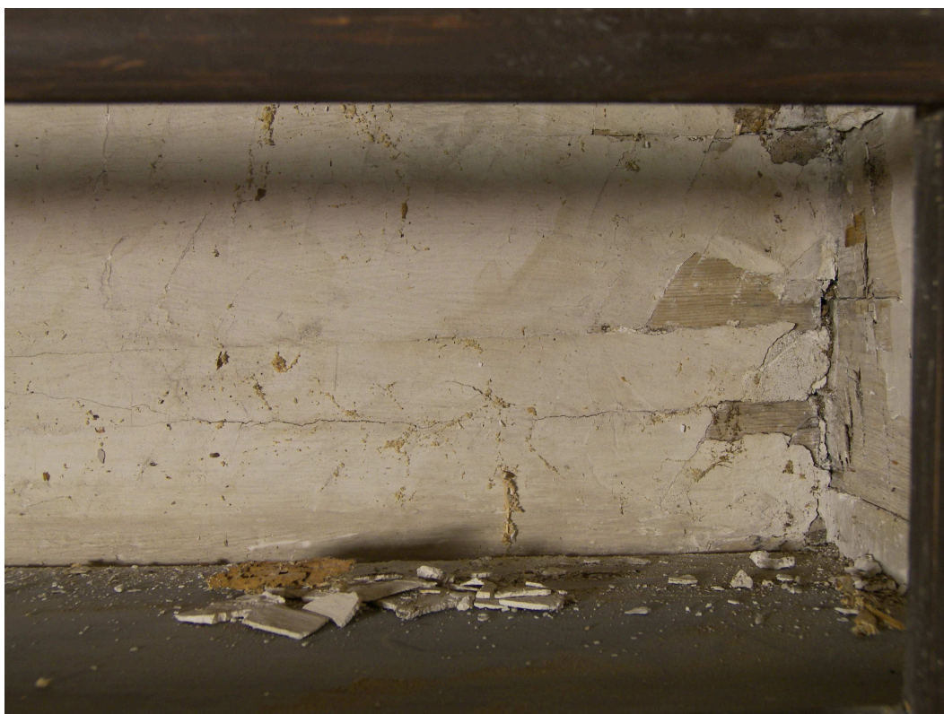
Detalj av originalputs, slagen direkt på putsen i ett varierande tjockt lager (1-3 mm).
