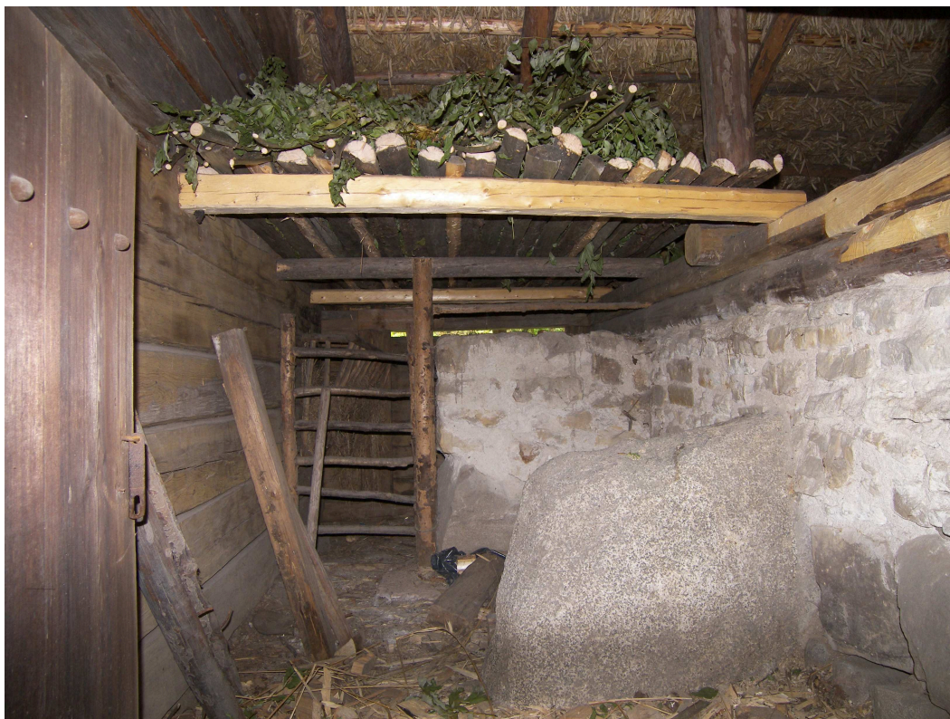
Innertaket över fähuset. Löst liggande räften av barkad och kluven gran har lagts på tre befintliga tvärgående bjälkar. På innertaket har foder av lövruskor lagts upp, i enlighet med beskrivningen i brev till Arthur Hazelius.
