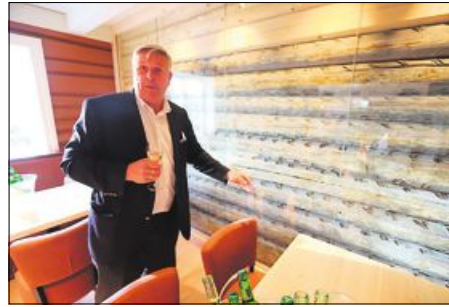
FORNØYD: Eier av Telegrafen Olav Dalen Zahl viser stolt fram den laftete veggen som er isolert med mose.
