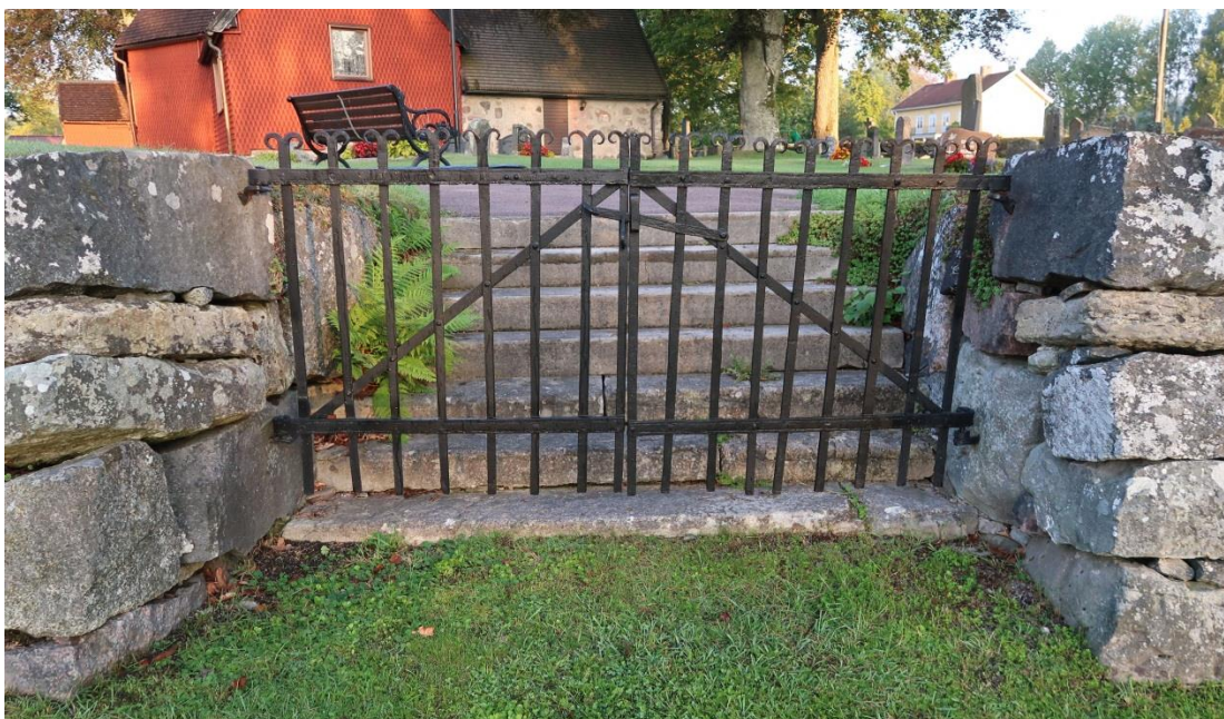
Integrerad enkel och smidd grind i östra stödmuren.
