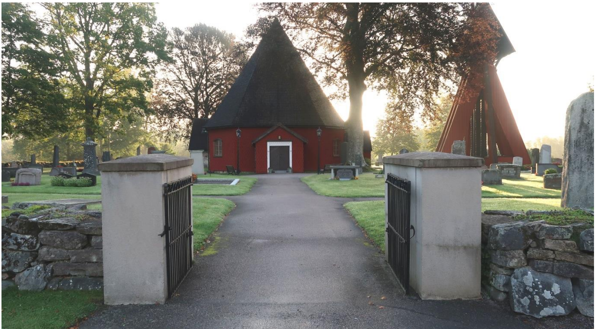
Västra entrén med putsade grindstolpar och smidda grindar som i storlek och utförande påminner om norra entréns grindstolpar.
