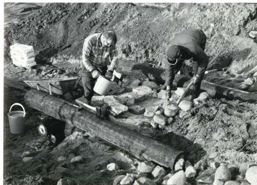
Ivar Berre og Håkon Sæle murer ovnen for myrmalmbrenning. Foto: O.T.L.
