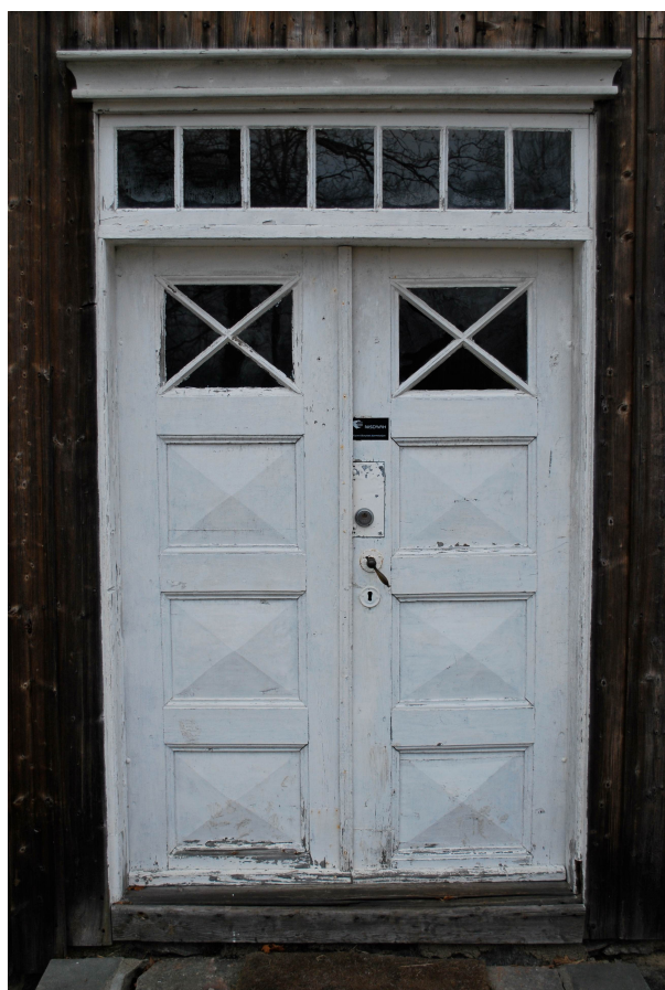
Dører fra Børsumbygningen t.h, og Holstad skole t.v. Begge dørene er laget i ramtrekonstruksjon.
