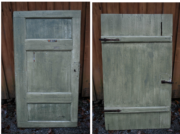
Labankdører fra Korsegården ca 1720. Utside t.v. og innside t.h.
