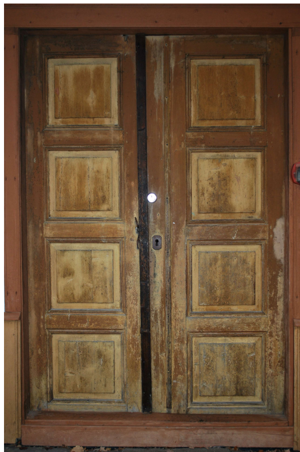
Dører fra Børsumbygningen t.h, og Holstad skole t.v. Begge dørene er laget i ramtrekonstruksjon.
