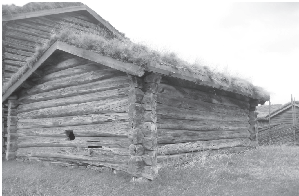
Tradisjonelt sauefjøs, bygd som et frittstående tømmerhus i én etasje. Eneste åpning for lufting og lys var den vesle gluggen i tverrvæggen. Gjennom denne ble gjødsla kastet ut når tallen skulle fjernes om våren. Husantunet, Alvdal. Nordøsterdalsmuseet, nr. 123112.
