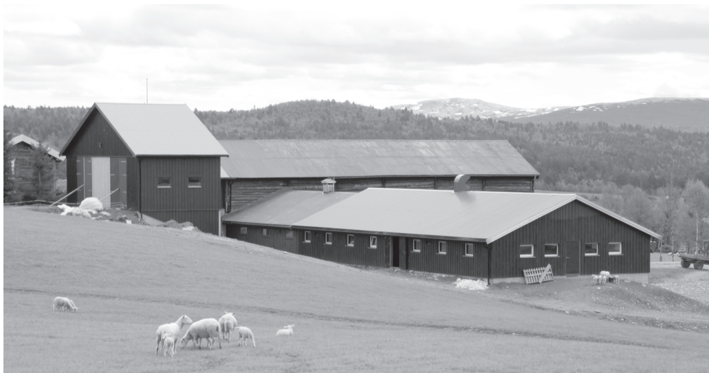
Nytt, isolert sauefjøs, bygd i 2010. Vingelen. Foto: Egil Simensen.
