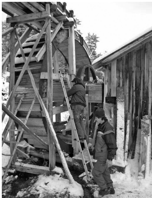
Restaurering av overfallshjulet i Mellomsbekken, Folldal. Torgeir Rennemo og Mohammad Ali har mange utfordringer.
