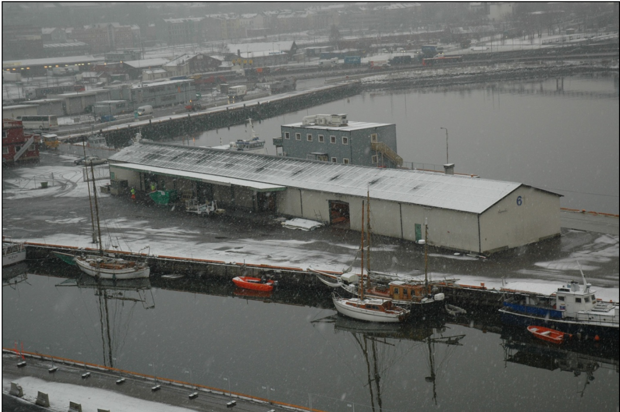
Figur 13. Prosjektkontoret Skur 61 på Paulsenkaia. Seinere ble ytterste del av skuret revet, fordi den kom i konflikt med traseen. På bildet er det fremdeles variert båtaktivitet langs Akerselva, og prosjektets båt (oransje Pioner Multi ) ligger fortøyd midt i bildet. SVRØs kontorbrakke er den røde helt til venstre i bildet.
