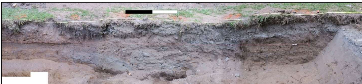
Figur 30. Snitt av dammen påvist i sjakt 2, profil C7. Det grå sandlaget lag 5 er synlig til venstre i bildet. Bildet viser et utsnitt av profil C7. Den svart-hvite målestokken er 1 meter. Foto mot nord, VTFK.
