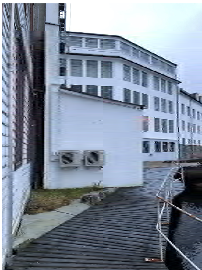
Nokre av dei nye varmepumpene som vart installert i 2022: innedel på syloftet, og utedelar på fabrikkbygningen mot sjøen.
