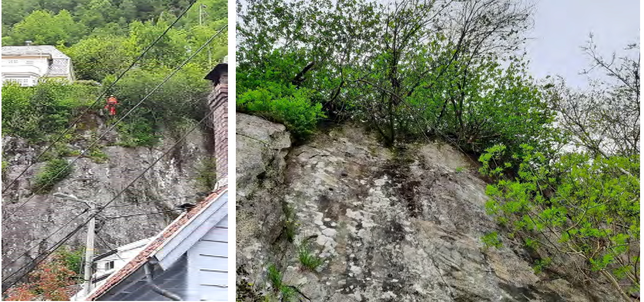
Sikring av skråninga bak skuret.
