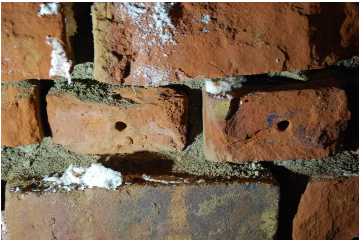
Figur 107: Hovedtestfelt på nordveggen i Sodahuset, ikke-klimatisert. Her får vi et inntrykk av hvordan teglveggen behandlet med saltkonvertering/magnesiumklorid virker fuktig, men at det fortsatt er noen «restsalter». Bilde fra september 2021.
