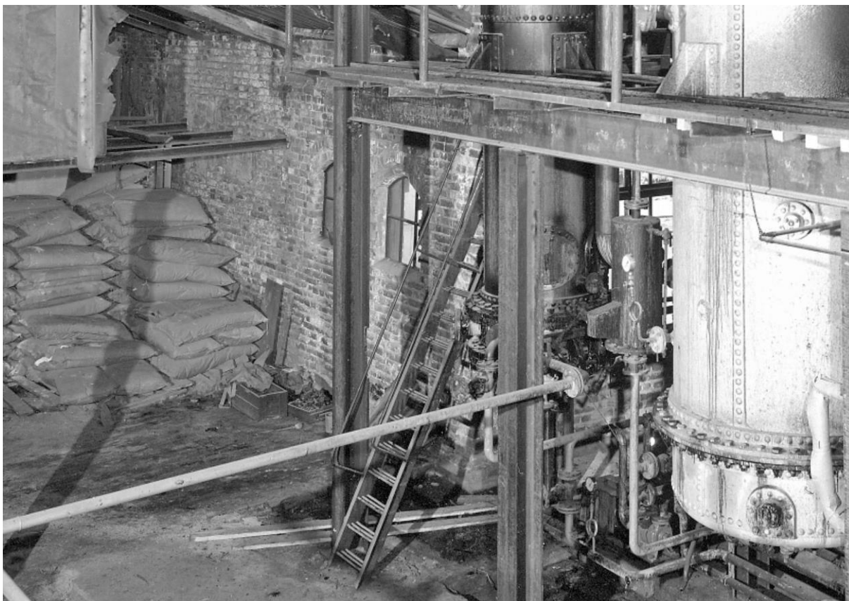
Figur 67: Ved siden av vakuuminndampingsanlegget i Sodahuset ligger det pent stablet sekker med natriumsulfat for bruk i soadovnene. Bildet trolig tatt omkring 1960. Mot slutten av driftstiden lå sulfaten i en åpen haug her, jfr. Figur 27. Foto: Anno Museum.
