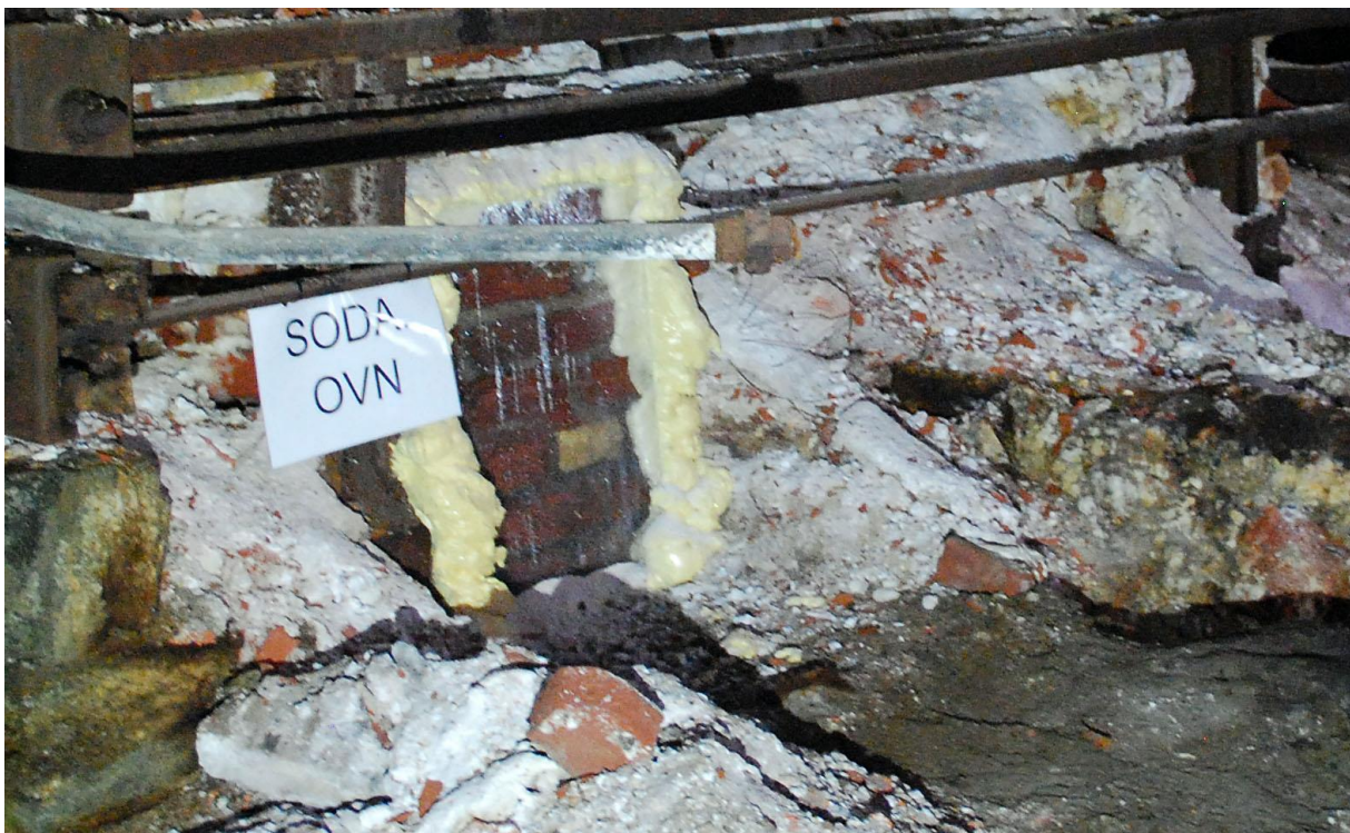
Figur 112: Plexiglass montert på nordsiden av den østre sodaovnen for å holde mikroklimaet på 100% luftfuktighet.
