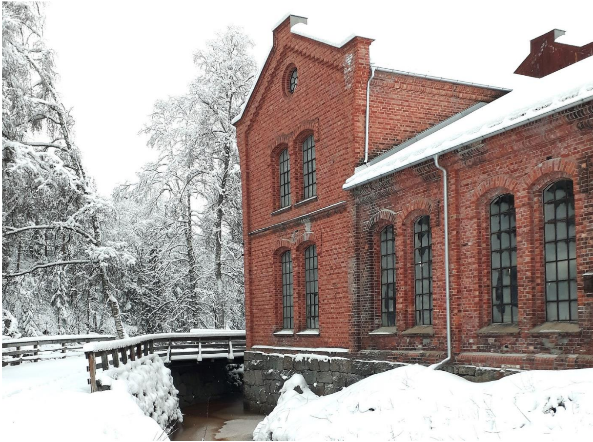
Figur 13: Solide granittfundamenter i det sørvestre hjørnet av Pakkeriet, nede på sletta, det laveste punktet i fabrikken der den møter utløpskanalen fra det interne kraftverket og Svartelva.
