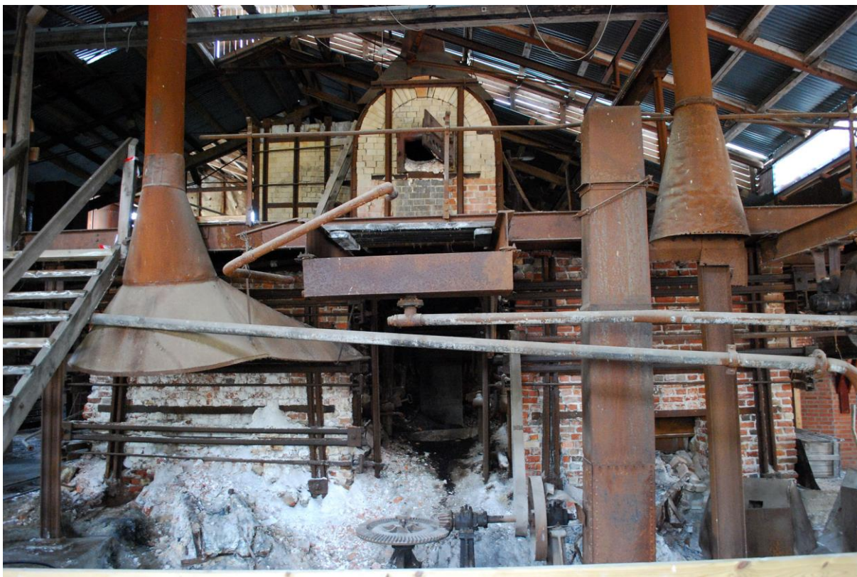
Figur 65: Hele sodaovn-anlegget sett forfra, med to ovner og pipeløp i gul ildfaststein over.
