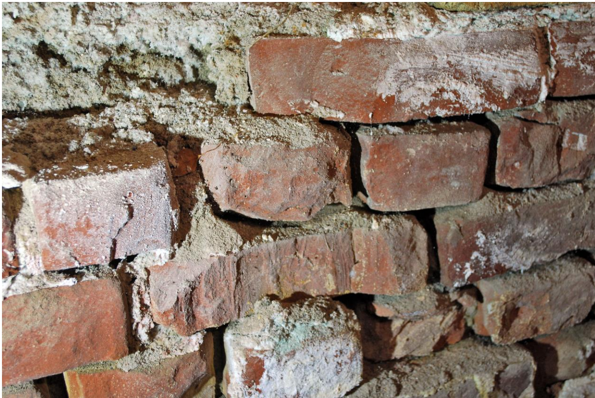
Figur 98: Forvitret fugematerial fra det ikke-klimatiserte, ubehandlede feltet på nordveggen. Her ser vi at mye «pulver» ikke kan falle ned på oppsamlingsbrett ved foten av veggen, men blir liggende i de dypt forvitrede fugene (30. september 2021).
