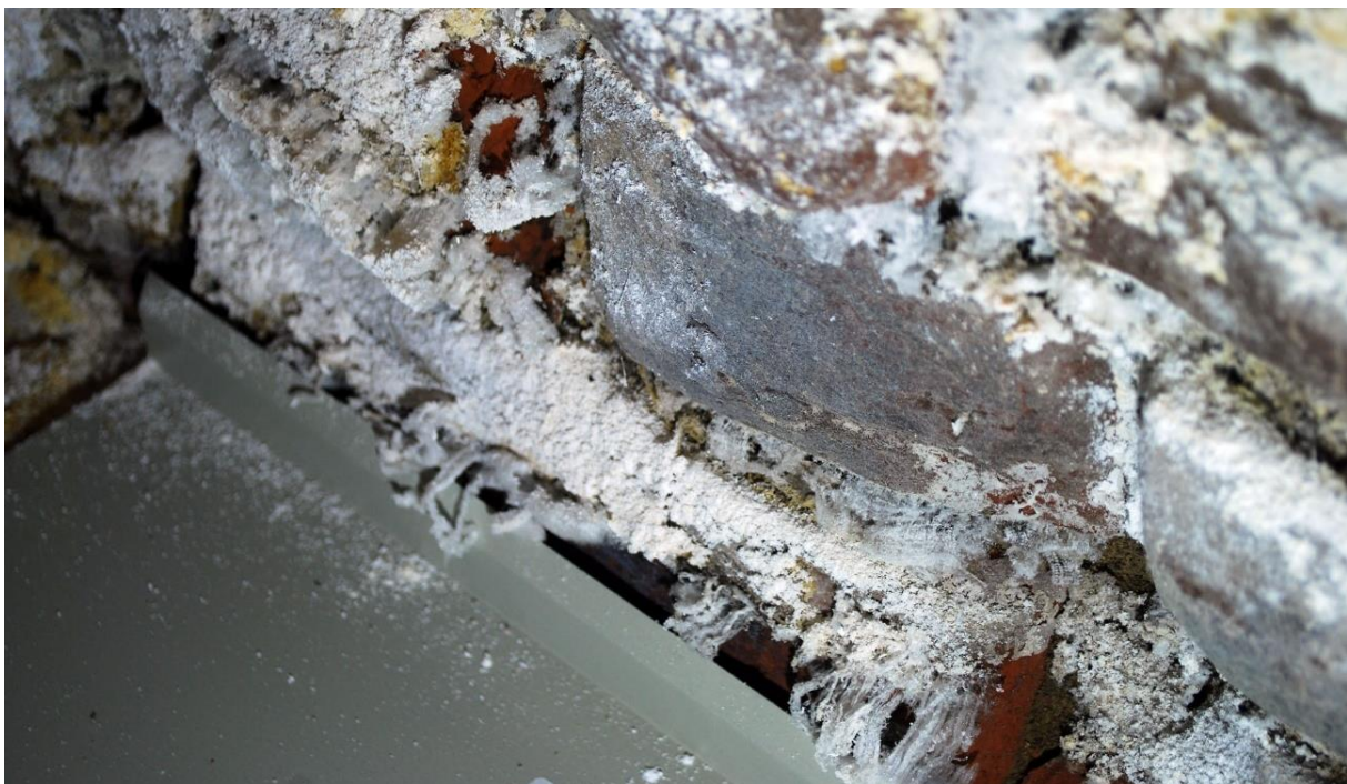
Figur 99: Heftig saltkrystallisering i form av tykke whiskers i den nedre delen av det klimatiserte, ubehandlede testfeltet på nordveggen i Sodahuset. Dette har med tilført grunnfukt å gjøre. Videre oppover veggens er saltene i delvis dehydrert form som følge av klimatiseringen. Foto fra 30. september 2021.
