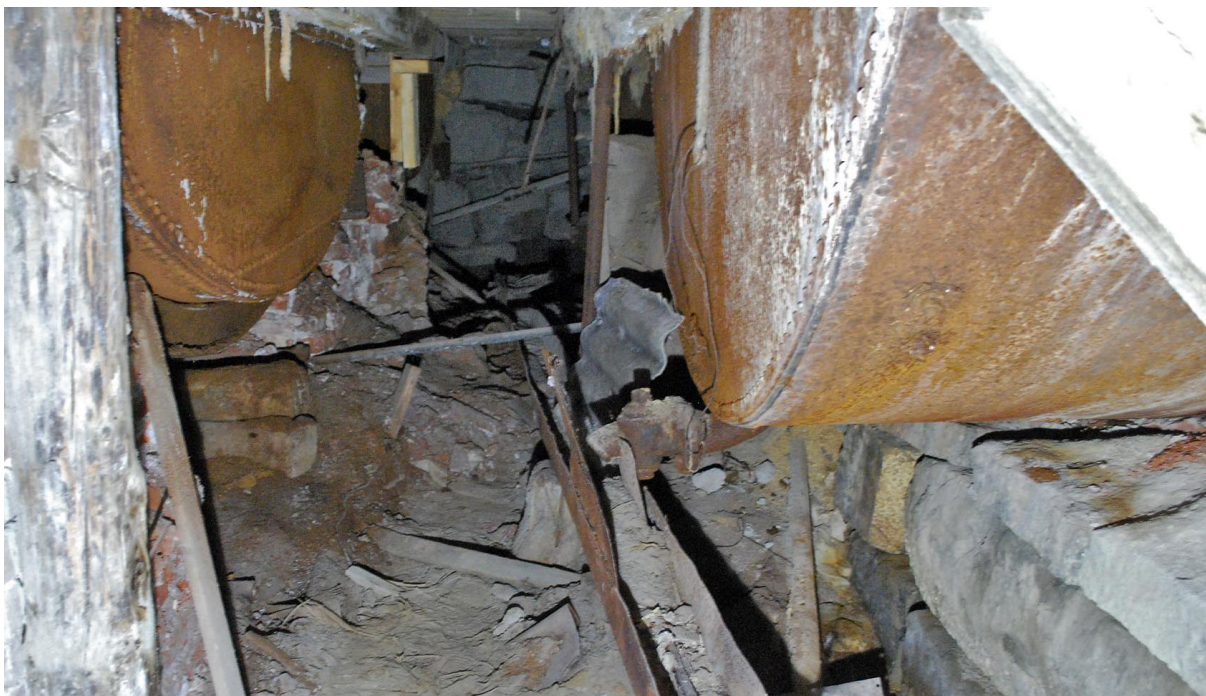
Figur 69: Luthuskjelleren, med undersiden av sandfileterkarene
