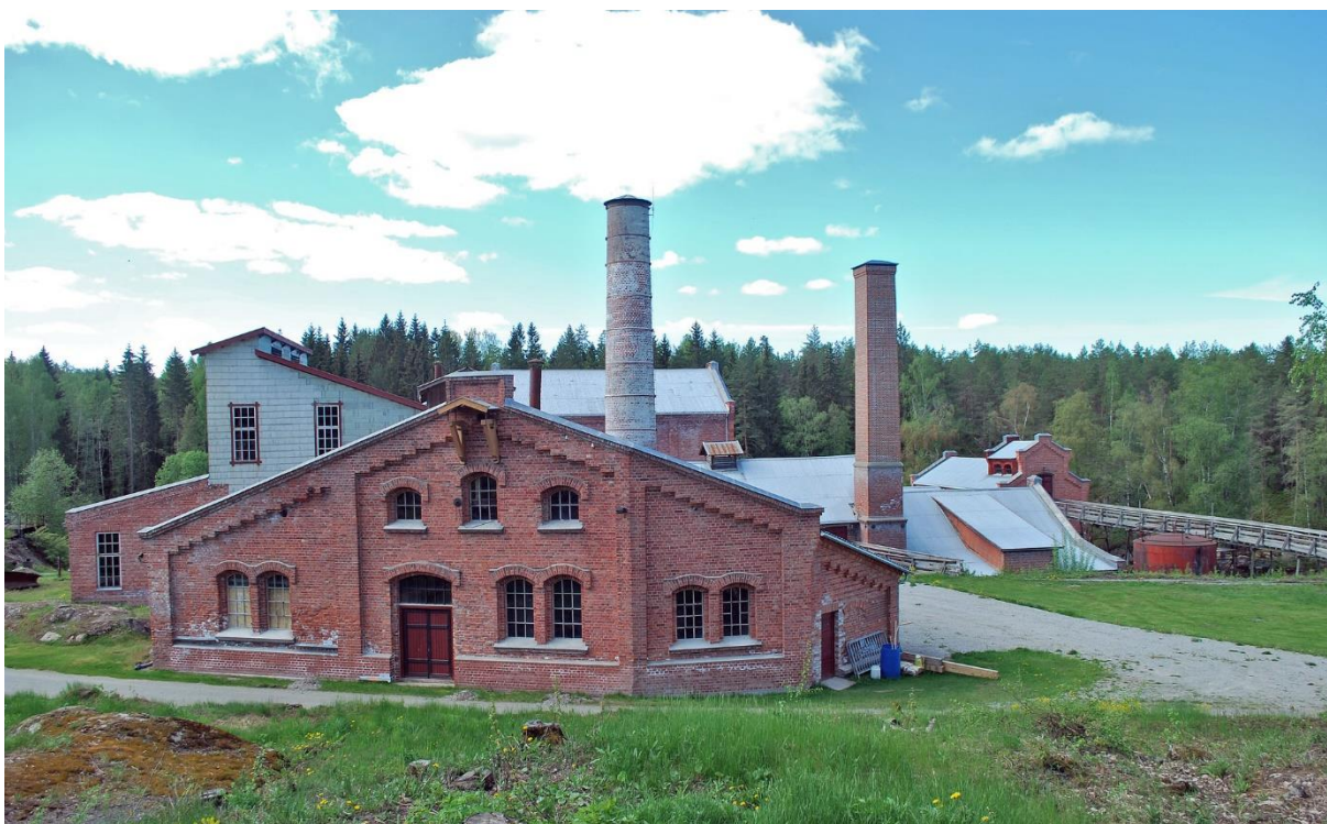
Figur 9: Fabrikken sett fra nord, rett mot nordfasaden av Sodahuset med platået og broa til Pakkeriet mot vest. Vi ser hvordan de lavere bygningsdelen «forsvinner» litt fra dette perspektivet.
