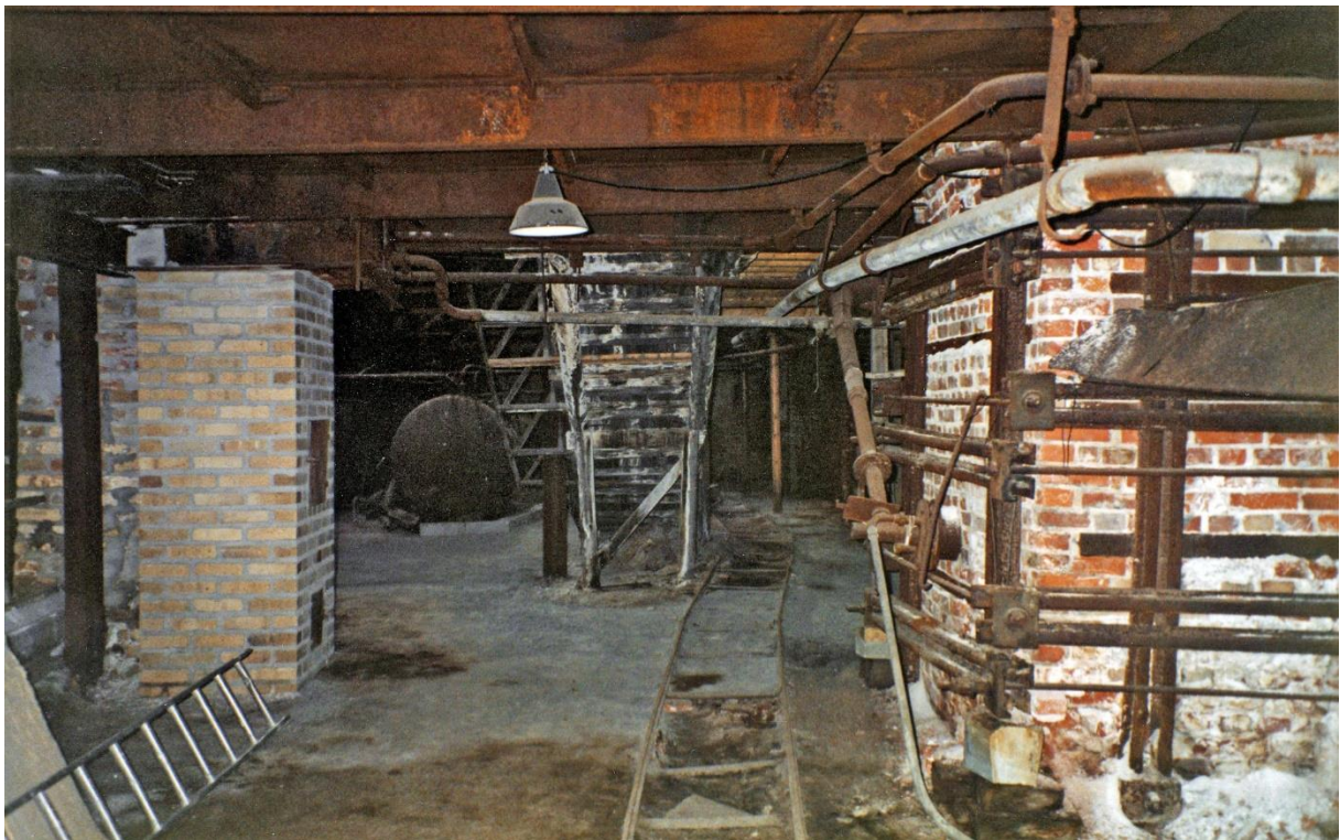
Figur 26: Innsiden av Sodahuset ca. 1989, med den østre sodaovnen til høyre. Saltforvitringen på ovnen er betydelig, men på langt nær så omfattende som i dag (jfr. Figur 2). Foto: Anno Museum
