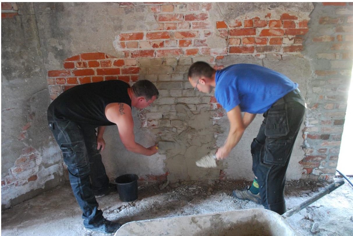
Figur 89: Morten Hjarnø (t.v.) og Maciej Wantola ved den første påføring av offerpuss i august 2020.
