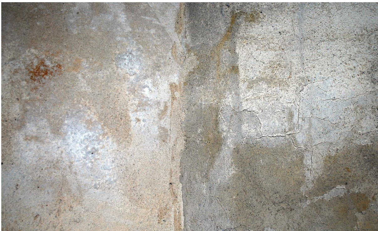
Figur 111: Nærbilde av de to pussmørtlene påført på nordveggen i Sodahuset i august 2021. Til venstre Målarkalk, til høyre hotmix med brent Franzefosskalk. Franzefoss er grålig i fargen siden den ennå ikke er særlig karbonatisert – og den oppviser store svinnsprekker fordi den var blandet for feit. Målarkalken er lett rødlig i fargen og viser ikke svinnsprekker. Begge kalkene tar opp salt og fukt.
