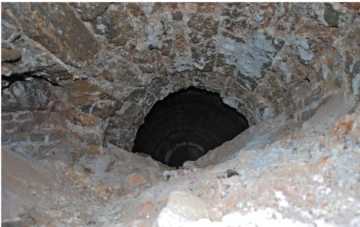
Figur 66: Pipeløpet og andre deler av ovnene er foret med spesialsåret kleberstein fra saghuset på Sagflaten ved Sel i Gudbrandsdalen. Her var det en betydelig eksportindustri for kleberforinger som kunne tåle høye temperaturer. Men vi ser at kleberen er sterkt skadet av høye temperaturer og salt fra røykgassene. Se bl.a. https://perstoremyr.net/2018/05/12/historien-om-et-saghus-i-gudbrandsdalen-produksjon-av-kleberstein-som-ildfaststein-til-smelteovner
