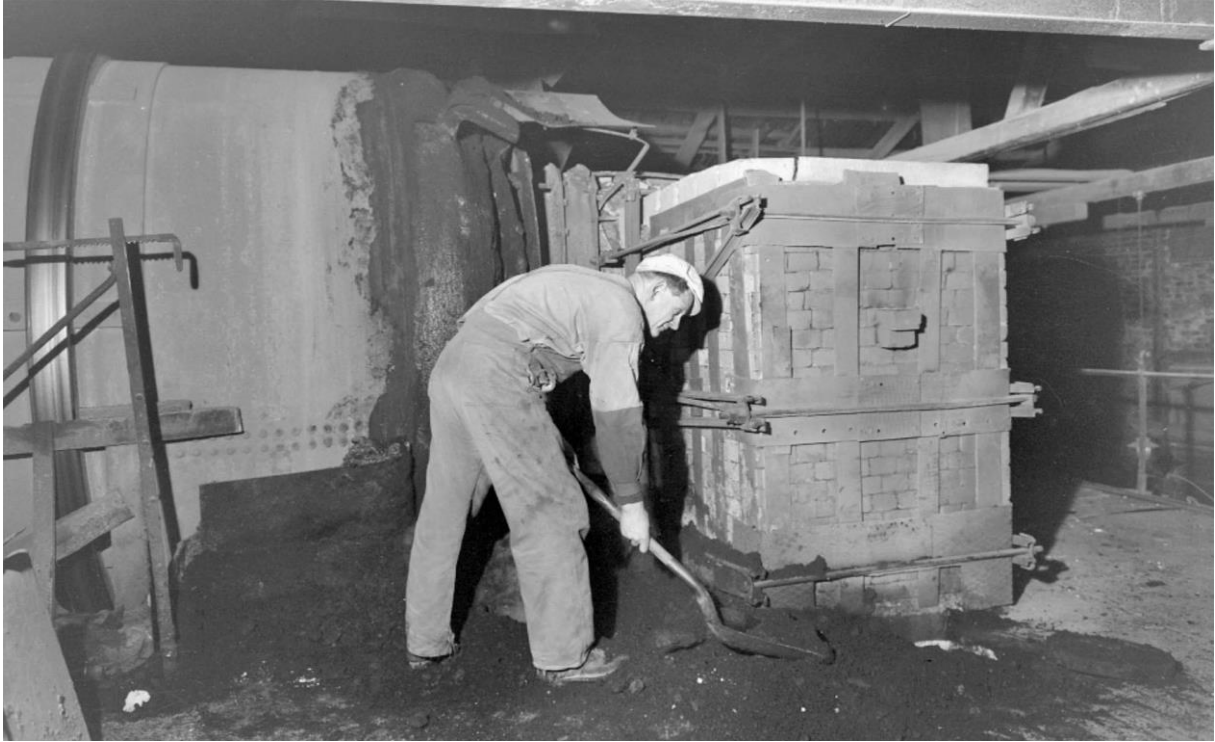
Figur 62: Ottar A. Skjerstad i ferd med å fylle sodaovnen i 1960. Dette gjøres manuelt gjennom et hull på toppen av ovnen etter at svartstoffet er kommet tørt ut fra roterovnen i bakgrunnen. Murkonstruksjonen er del av pipeløpet fra ovnen; røyken går videre tilbake gjennom roterovnen og varpa. Foto: Anno Museum.
