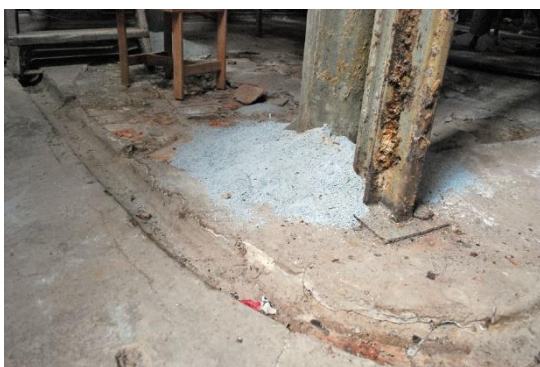
Figur 54: Liten dreneringskanal på gulvet i Kokeriet.
