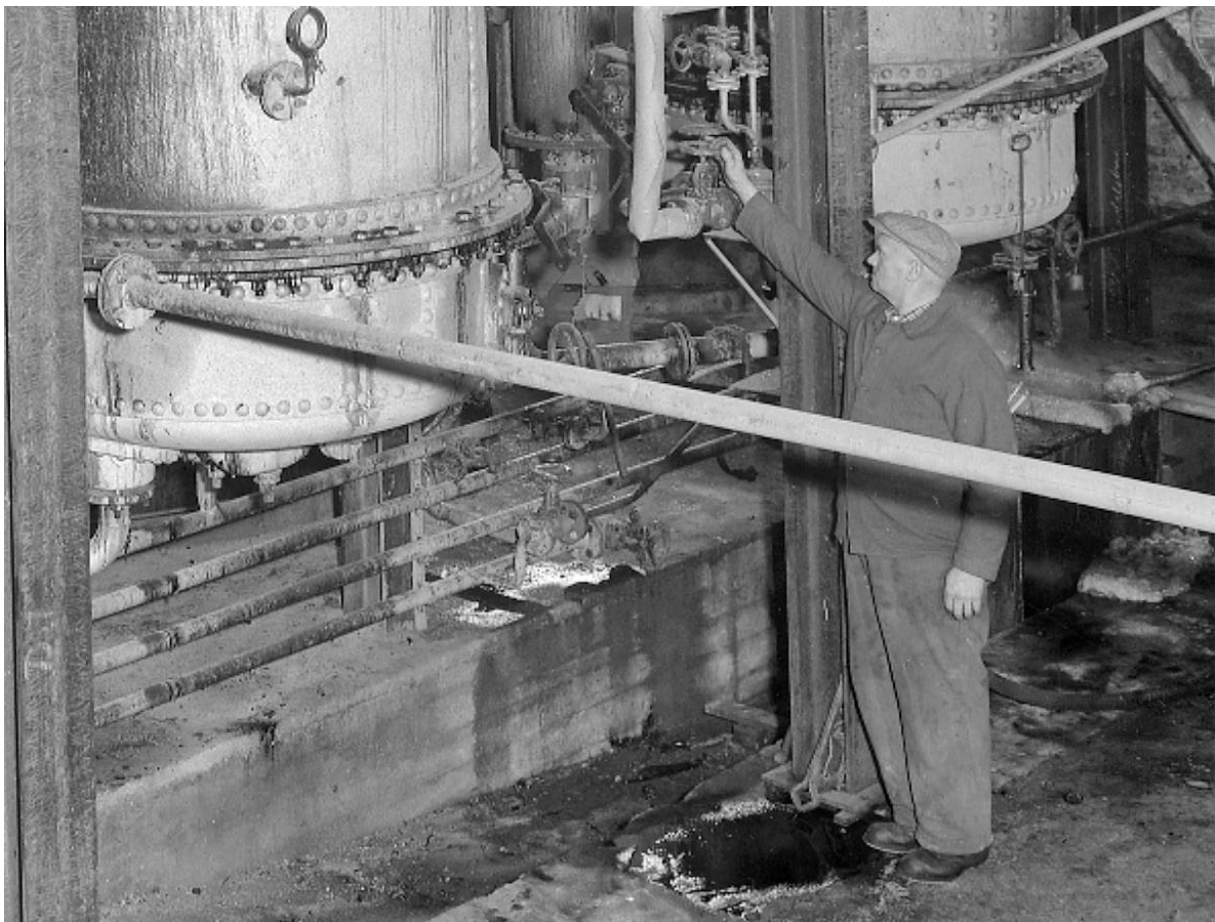
Figur 57: Utsnitt foto fra vakuuminndampingsanlegget i Sodahuset. Legg merke til spill av svartlut. Udatert, Anno Museum.
