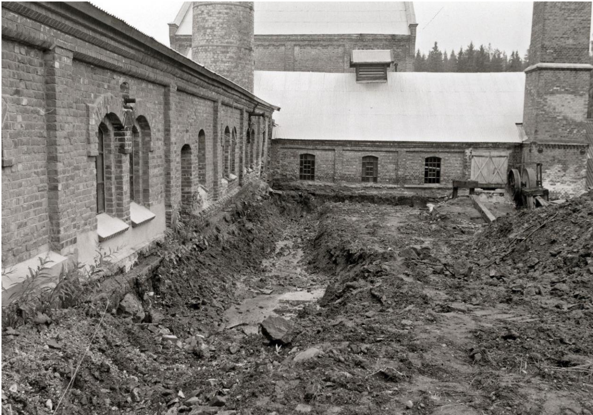
Figur 21: Grøfting i 1984 for å bedre dreneringen langs Sodahusets vestvegg og Luthusets nordvegg. På bildet ser vi også at mesteparten av vestveggen er satt i stand siden 1978. Det gjelder bl.a. også sodahuspipa. Foto: Riksantikvarens arkiv.
