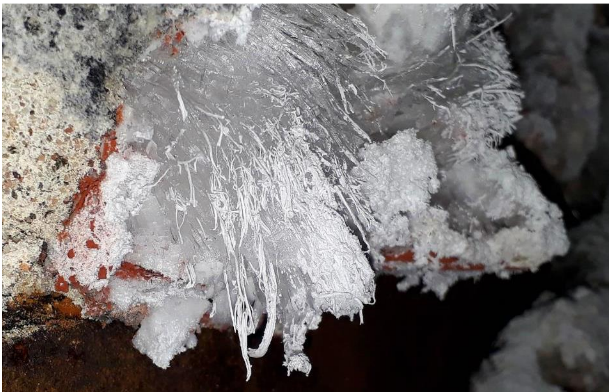
Figur 35: Stor forekomst av natriumsulfat på den østre sodaovnen. De glinsende delene av saltet er nåler av mirabilitt, i de hvite delene er mirabilitten i ferd med å dehydrere til thenarditt. Foto fra midten av mai 2020, da relativ luftfuktighet i Sodahuset hadde sunket til 50-60%.
