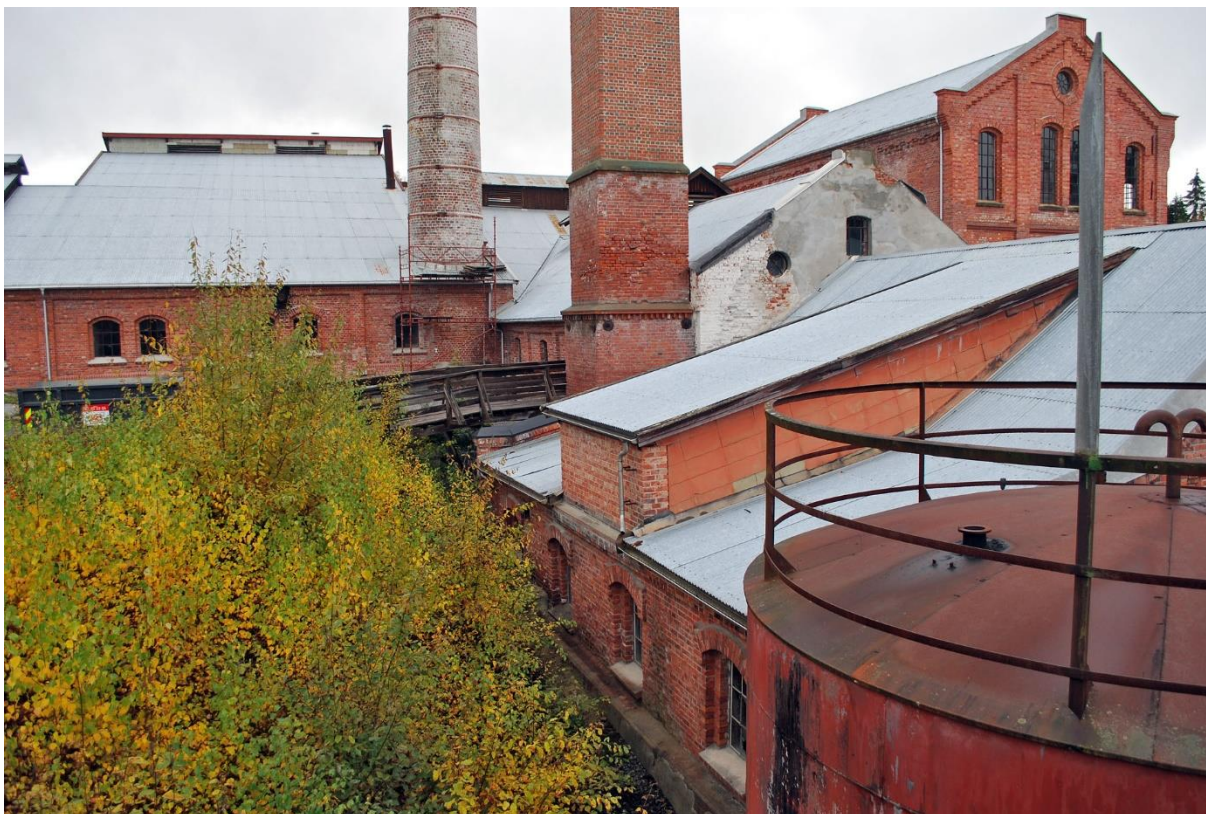
Figur 8: Fra broa over til Pakkeriet ser vi fra vest hvordan Fyrhuset (med oljetank i forgrunnen) og Luthuset (med pusset gavl) ligger lavere enn Sodahuset (oppe til venstre). Vi ser også Fyrhuspipa (forrest) og Sodahuspipa. Kokeriet troner i bakgrunnen. Det ligger på sletta, fundamentert ca. 6 m lavere enn Sodahuset, men er den høyeste bygningen i Fabrikken.
