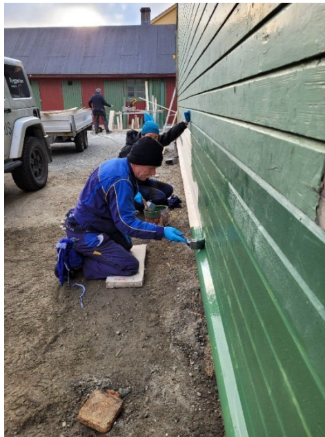
T.v.: Vindauge kjellar i Folgefonngata 9. Foto: Svein Jåstad, Kraftmuseet. T.h.: Skifting av bord og måling i Folgefonngata 13. Foto: Åsne Dolve Meyer, Kraftmuseet.
