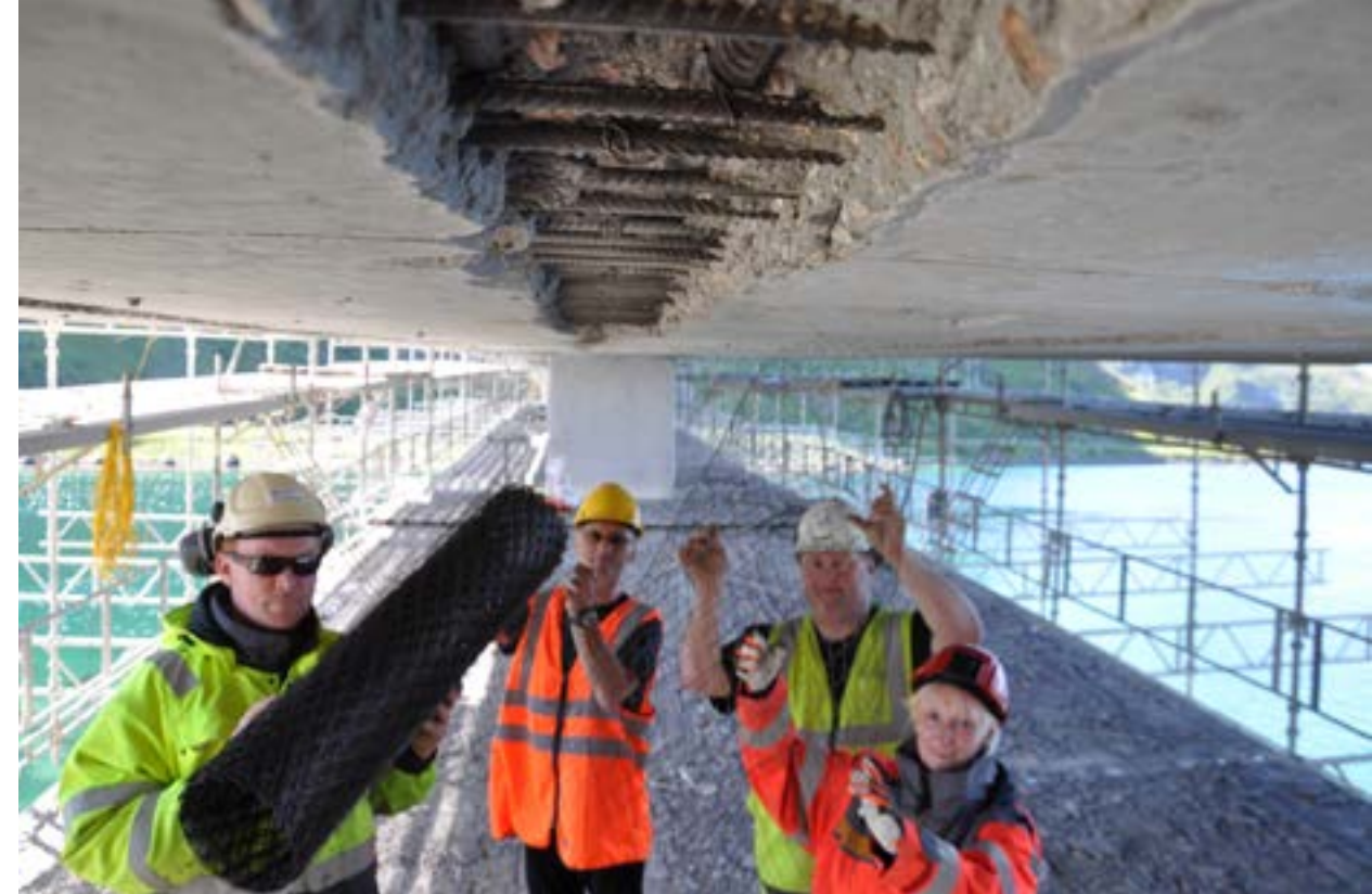
Støpebetong måtte tas av med sandblåsing og erstattes med sprøytebetong da et titannett ble montert under den 37 år gamle Sundklakk bru i Lofoten i 2013 for å stanse armeringskorrosjon og sikre lang levetid. Fra venstre Knut Einar Riise fra leverandøren Corroteam AS, Vegdirektoratets bruseksjonsleder Børre Stensvold, Pål Øystein Jakobsen fra Consolvo AS som utførte arbeidet på brua, og Vegvesenets byggeleder Linda Hansen. (Foto: Håkon Aurlien)
