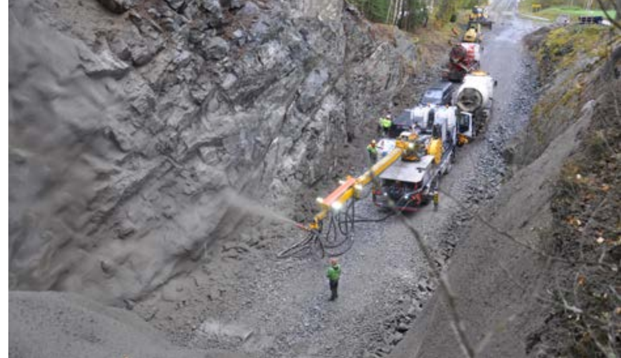
Betongsprøyting ved Rustantunnelen på fv. 40 i Numedal i 2019 (Foto: Kjell Wold)
