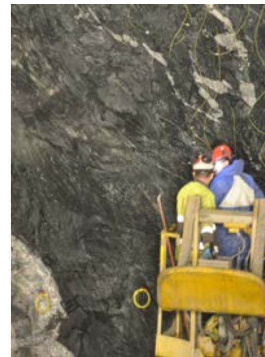
Ved tunnelbygging brukes sprøytebetong til arbeidssikring i hele Europa. Det er viktig at geologer ser fjellet før sprøyting, slik at svakheter ikke blir dekket til. (Foto: Håkon Aurlien)
