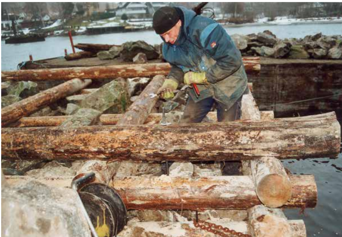
Konstruksjonen skrus sammen.
