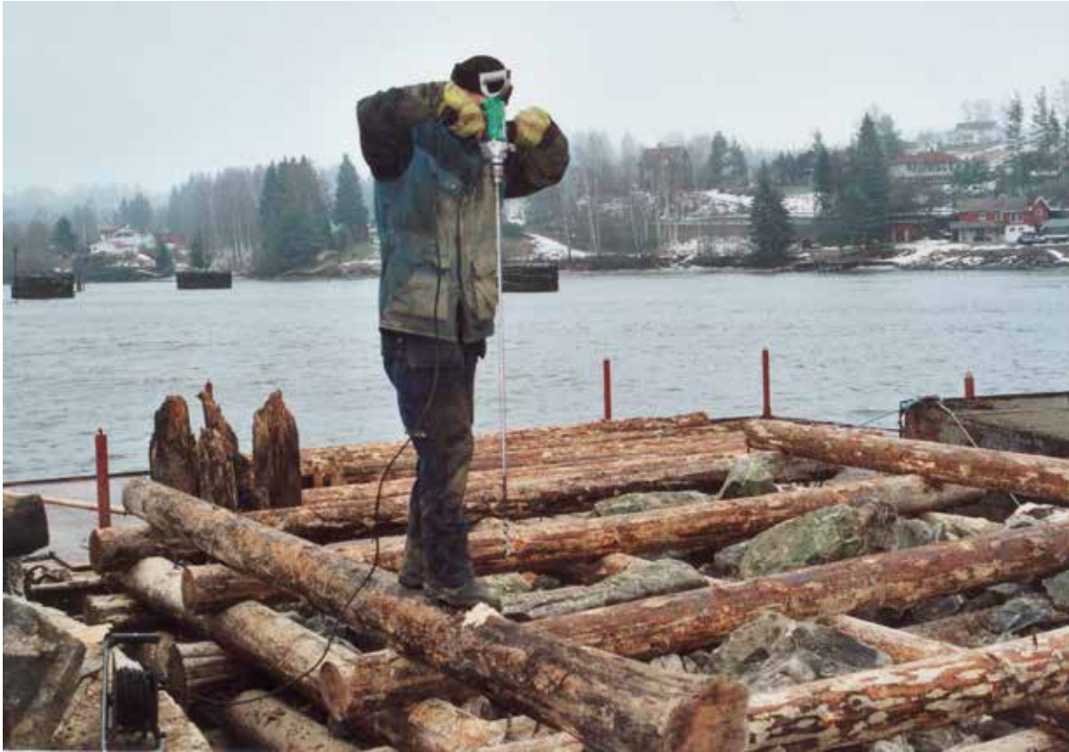
Haakon Skoglunn borer hull til stag som skal holde laftekonstruksjon sammen.
