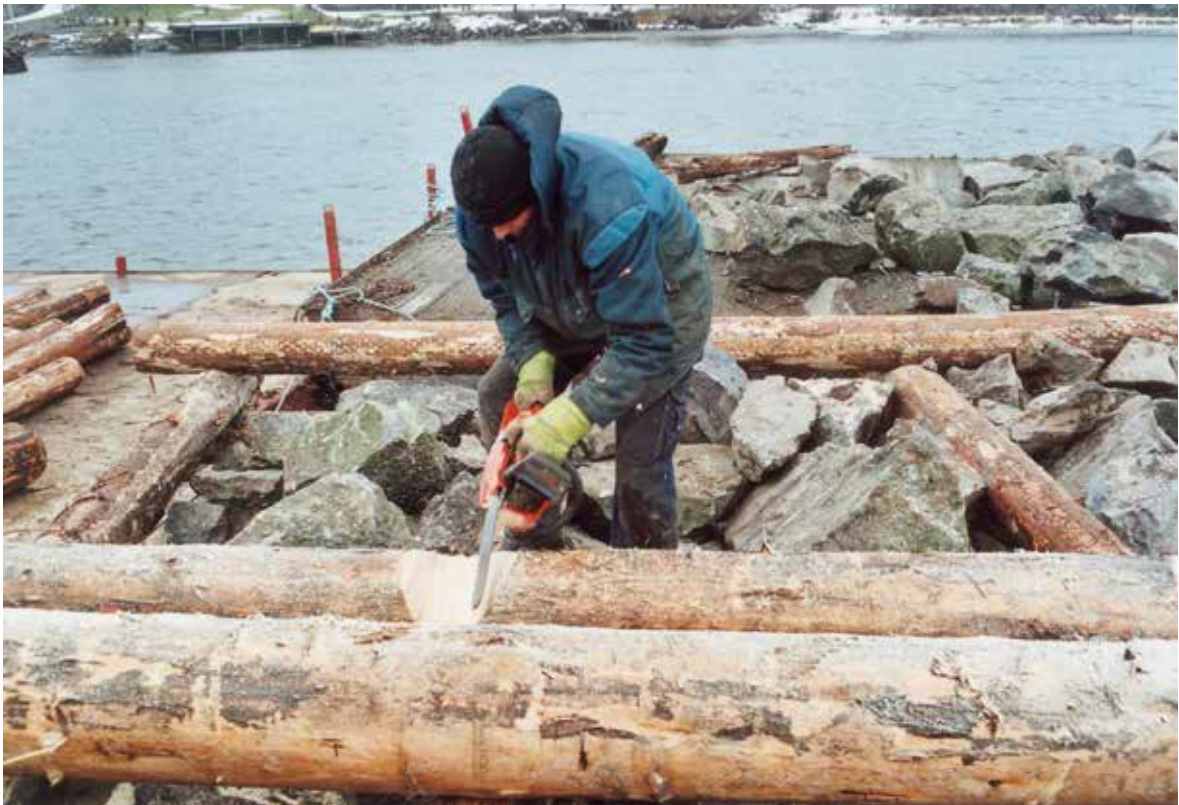
Det sages et spor før laftestokken monteres.
