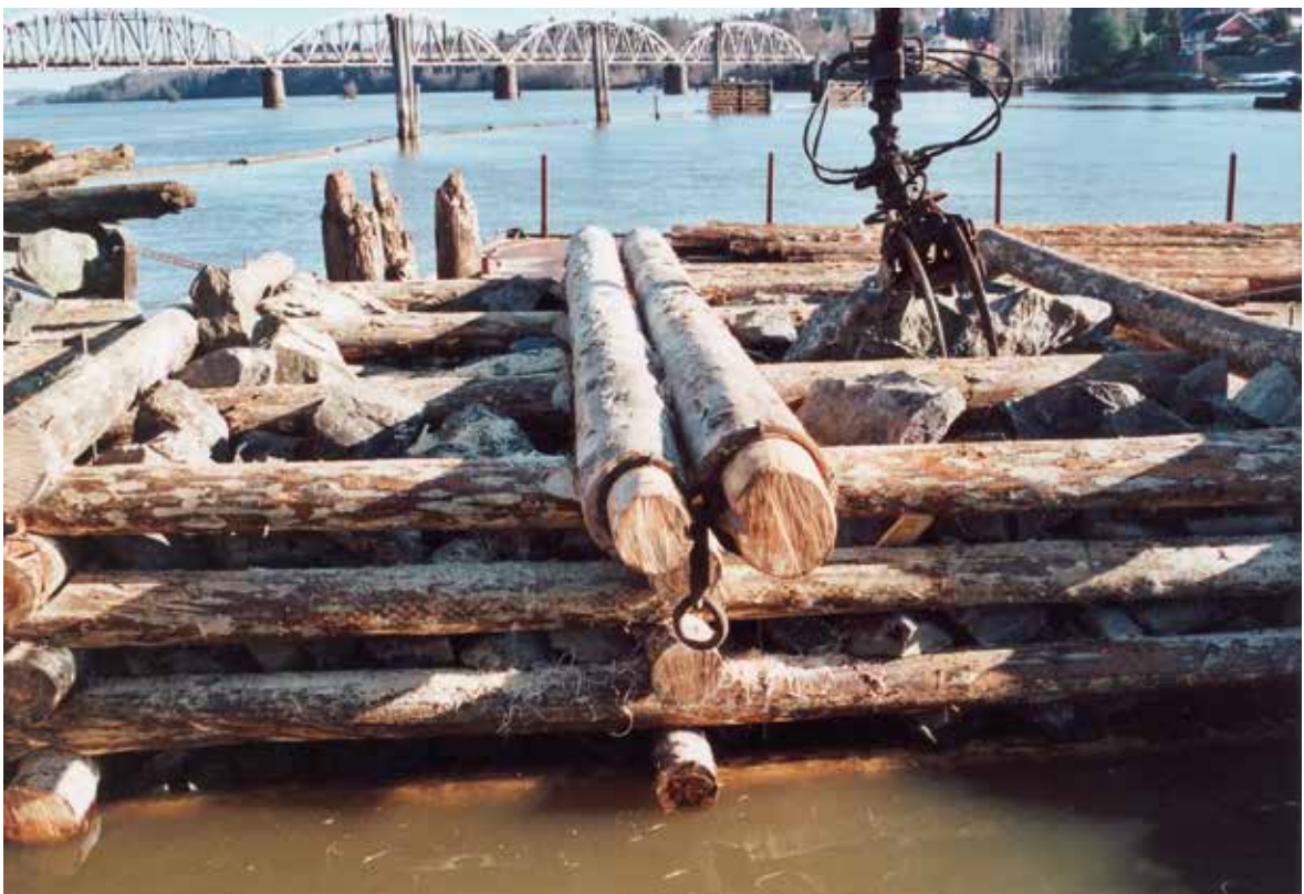
De to fortøyningsstokkene med dobbeltredskap er montert.
