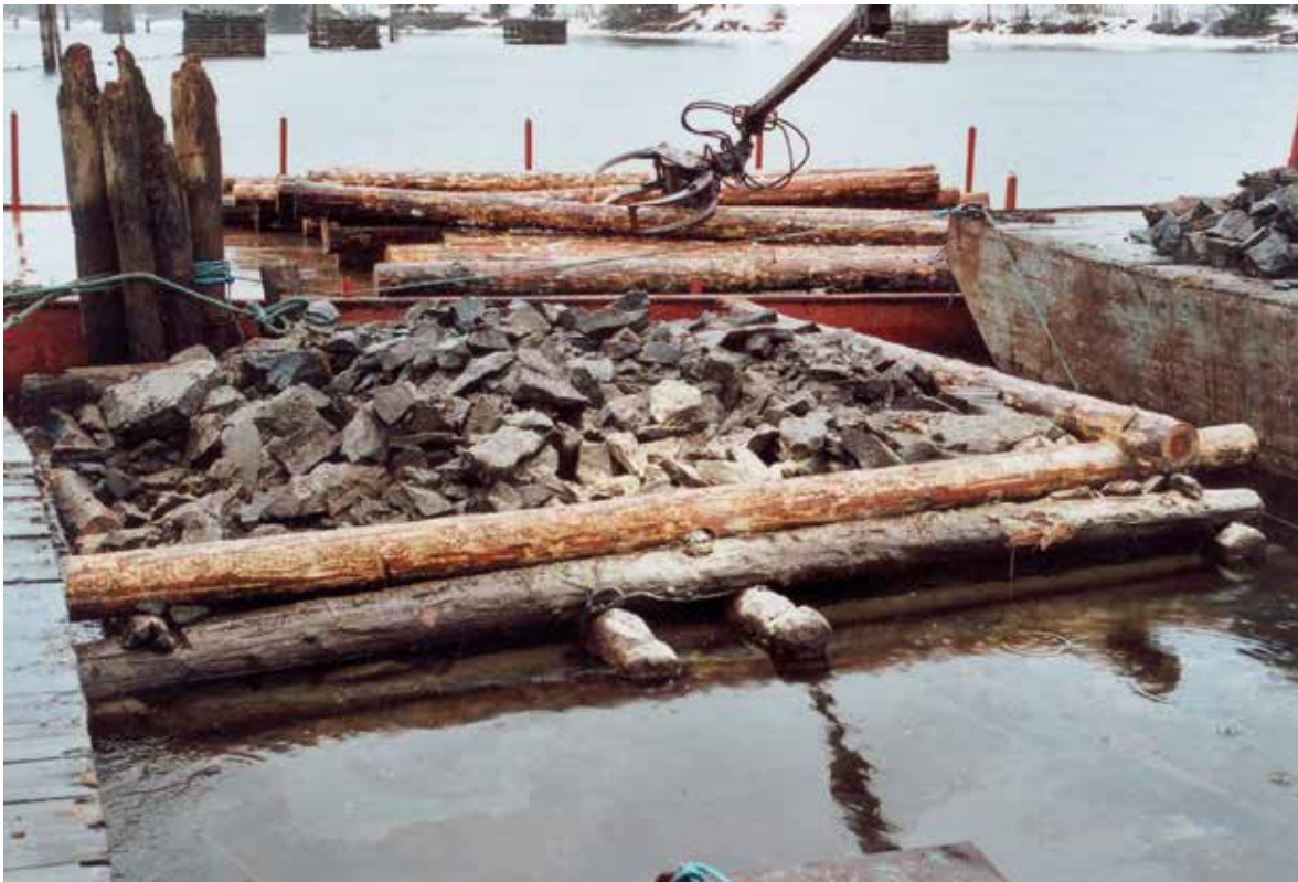
Karet laftes opp på nytt. Legg merke til gammelt feste for lenserekken nær elvebunnen
