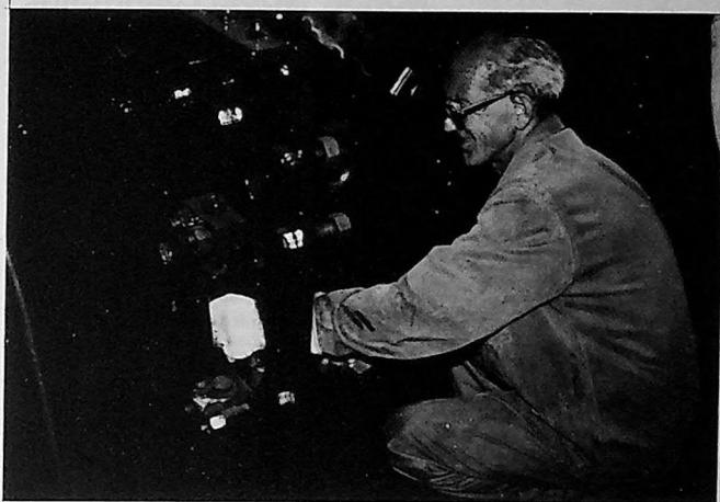
Willy Haugen i aksjon med å brosjje opp et hull etter en nylig utbrent nagle.
