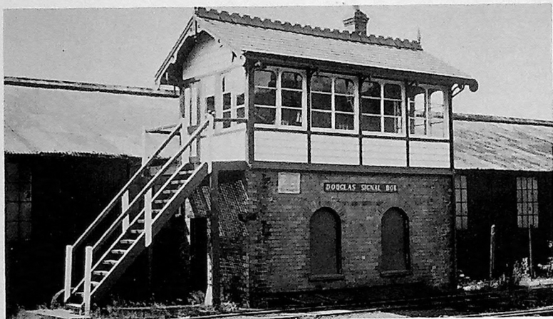
"DOUGLAS SIGNAL BOX". Vognhallen i bakgrunnen. Foto: Finn Halling
