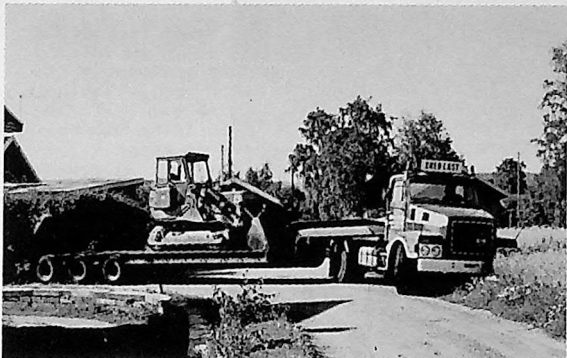
Rundt "hårnål-svingen" ved Fossum med dozer fra Pay & Brinck A/S.
