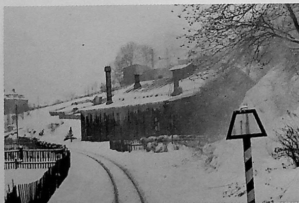
Lokstallen, Jöhstadt sett fra bakerste plattform. Bemerkt trapes- tavlen (innkjørssignal).
