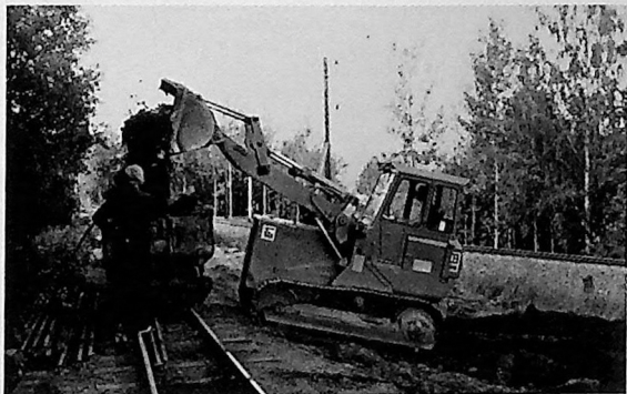
Samtidig med planering for vognhallen ble overskuddsmasse benyttet til forsterkning av ballastkanter i øvre del av Bingsfoss stasjon. Sidetipp-vaggene kom her til sin fulle rett.
