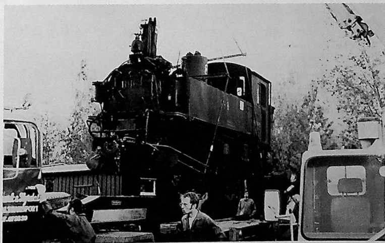
En 40 tons mobilkran løfter loket over fra bil til bane. Det var litt trangt om plassen, men ved å løfte loket over taket på "stasjonsbygningen" gikk alt greit.
