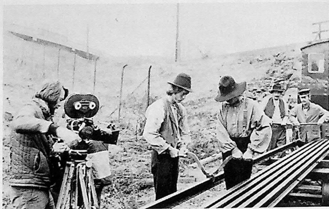
Svein Bæren gjør klar for detaljopptak av hvordan skinnene løftes av trallene før de bæres frem på svillene.
