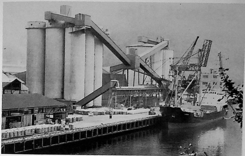
NORSK ALUMINIUM COMPANY, HØYANGER, KAI- OG SILOANLEGG. RÅDGIVENDE INGENIØR: INGENIØR CHR. F. GRØNER A.S.
