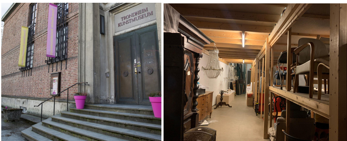
Til venstre, foto av TKM sin hovedinngang som har utfordringer mtp universell utforming. Til høyre foto av lager/magasin på loftet i NKIM. Samlingen til museet er stor og har vært lagret under dårlige forhold.
