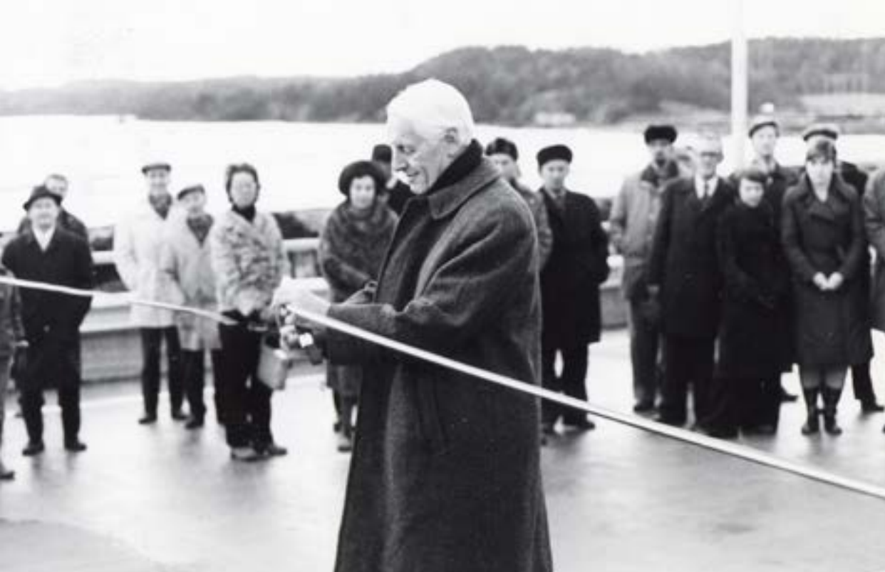
Vegdirektør Olsen åpner Norges første treplankryss på E-18 Farriseidet utenfor Larvik i mars 1973.
