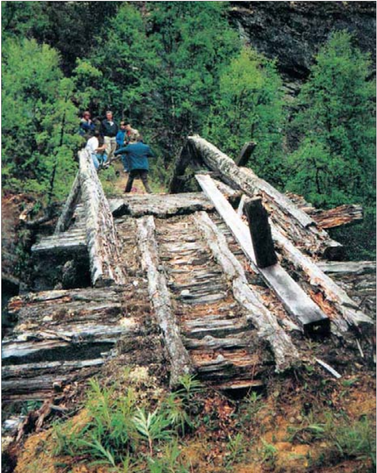
Etter Magnus Lagabøters landslov lå også vedlikeholdet av bruene til bøndene, men mange bruer kunne nok være like skrøpelige som denne utleggerbrua fra Visdalen i Lom synes å være. Foto: Geir Paulsrud.
