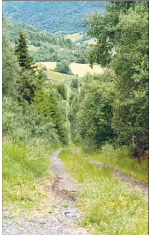
Den Bergenske Kongevei som gikk mellom Oslo og Bergen ble bygd omkring 1800 etter det franske byggeprinsipp med rette linjer. Dette bildet er fra Vang i Valdres, Oppland fylke. Foto: Cathrine Thorstensen.
