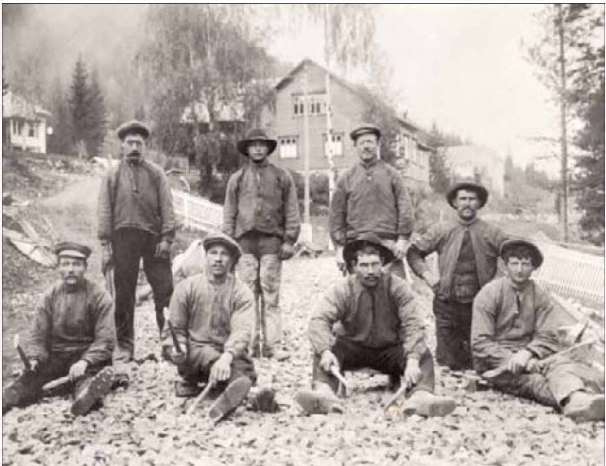
Uavhengig av den teknologiske utviklingen har mennesker alltid vært involvert ved vegbygging og vedlikehold. Her arbeides det med håndpukking på Fagernes, like ved utgangspunktet for Rv 51. Vegarbeidet begynte i 1912, og bildet er trolig tatt samme år. Norsk vegmuseums fotoarkiv.
