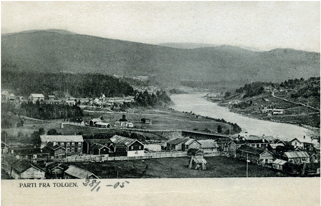
PARTI FRA TOLGEN: Et av de tidligste kortene fra Tolga, med bakside kun til navn og adresse. Først i 1905 ble det lov til å skrive melding eller hilsen på baksiden. Dette er grunnen til at mange av de aller eldste kortene har fullstendig nedskrevne forsider. Bildet er tatt omtrent der hvor Gammelskolen ligger nå. Ukjent utgiver.
