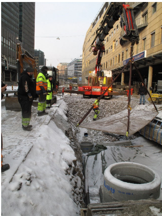
Figur 10 Representanter fra Aktiv Veidrift overvåker arbeidet med påleggingen av stålplata over vraket. Foto tatt mot NV. Foto NMM.
