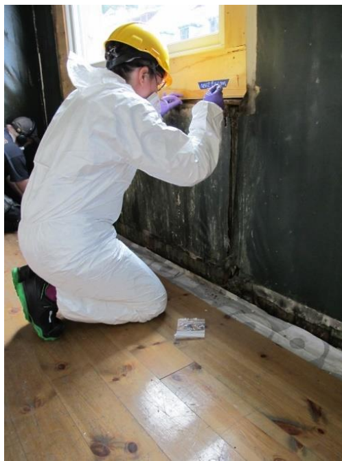
Demontering av tapet, Hanseatisk museum
