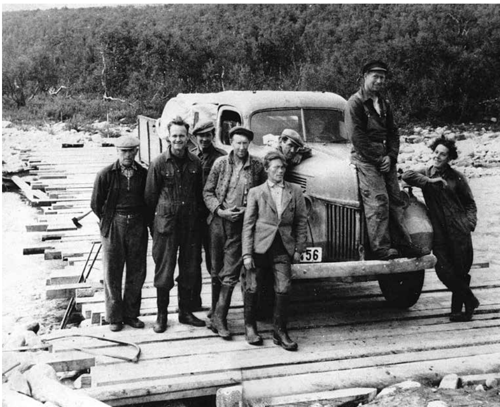
Etter iherdig arbeid var Storelva bru på Børselvfjellet farbar igjen klokken 05.00 den 1. august 1946. Her en av de første bilene over med fra venstre: Erling Akvik, formann Egil Foslund, John Johansen, Einar Glørsen, Bjarne Lilleng, Hans Hansen, Kåre Moeng, Johan Relart Johnsen. Bilens eier er Motrøen (stående på bilen). (Foto: fra Godfred Karlsens samling ved NVM)
