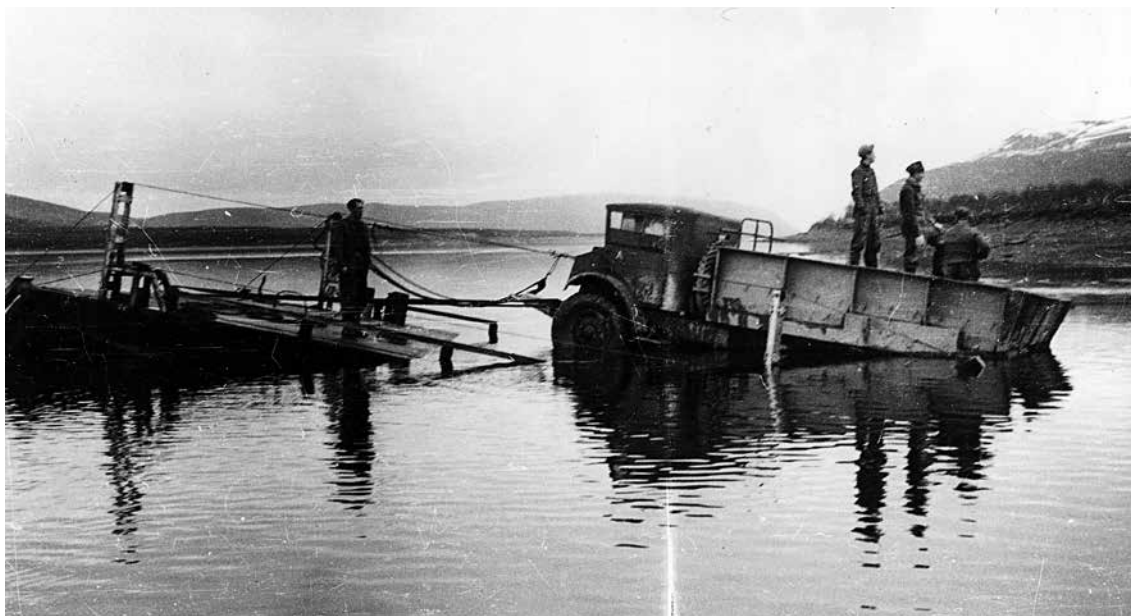
Seida ferge over Tanaelva sank på grunn av et for stort sementlass. (Foto: Arne Inge Torvik)
