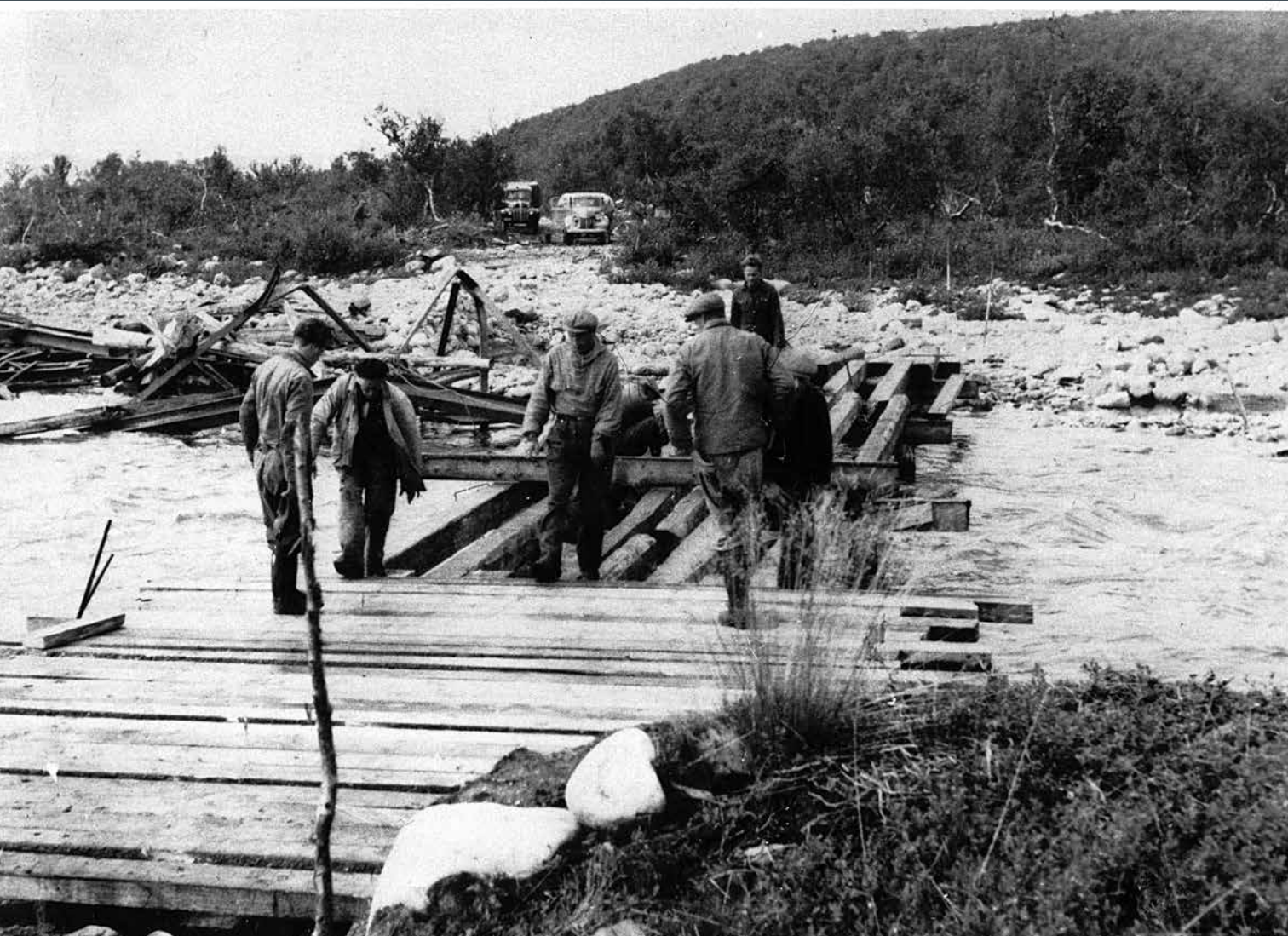
Da tyskerne trakk seg tilbake ble Finnmark og nordre deler av Troms ødelagt etter "den brente jords taktikk" – 266 bruer var ødelagt, og mange måtte repareres provisorisk som denne over Storelva på Børselvfjellet. Her er det Egil Fosslunds arbeidslag som er i sving. (Foto fra Godfred Karlsens samling ved Norsk vegmuseum)
