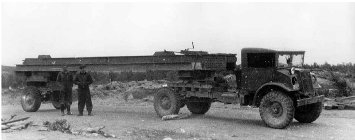
Transport av tårndeler til Tana bru. (Foto: Nils E. Hertzberg/Godtfred Karlsens samling/NVM)
