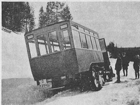
I grøften med det ene belte.
