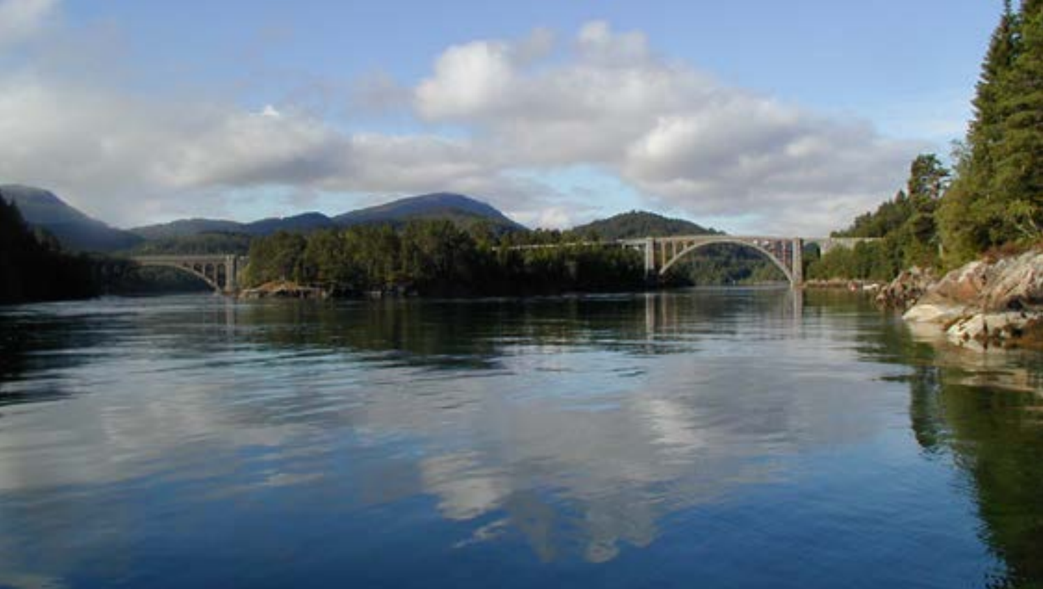
Skodjebruene med sine hovedhvelv i naturstein og mindre hvelv i teglstein og uarmert betong. (Foto: Jørn Arve Hasselø)
