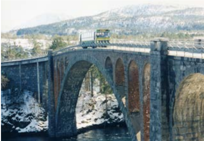
Skodjebruene var dimensjonert for hest og kjerre, ikke for et økende omfang av kjøretøyer i ulike størrelse. Det ble innført akselastrestriksjoner, men fristelsen til å kjøre over brua var likevel stor. (Foto: Per Austnes)
